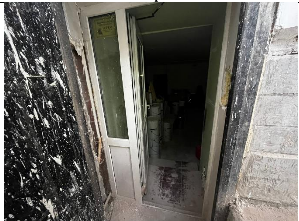
Фото 4. Общий вход с улицы
