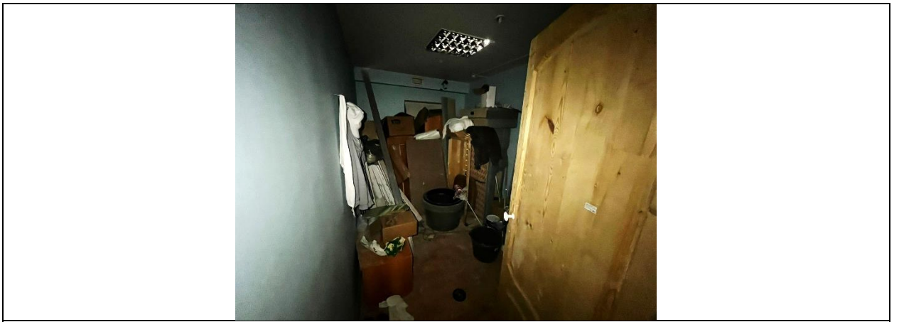
Фото 9. Внутреннее состояние Объекта оценки
