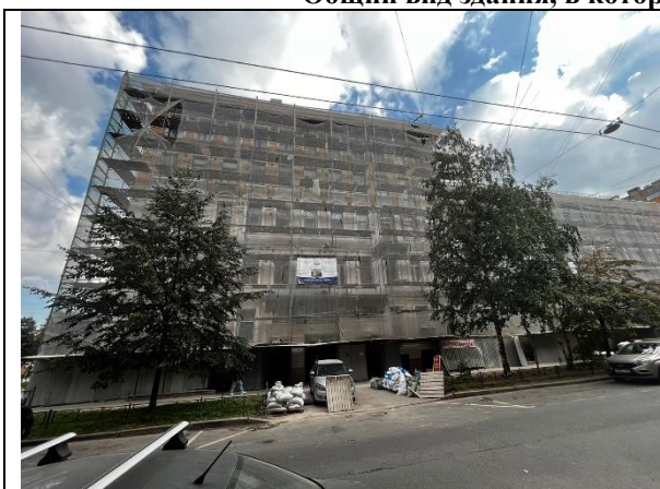
Фото 1. Вид здания, в котором расположен Объект оценки
