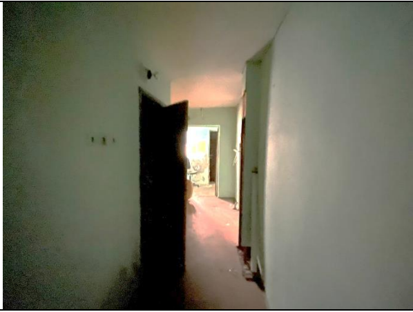
Фото 61. Типичное состояние Объекта оценки
