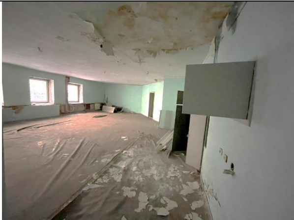
Фото 63. Типичное состояние Объекта оценки
