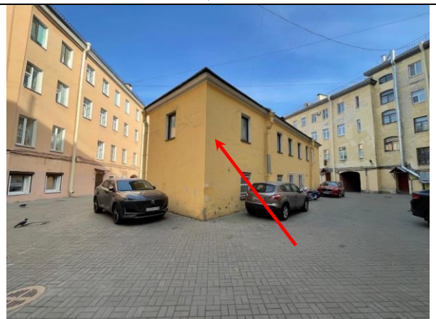
Фото 22. Вид здания расположения Объекта оценки
