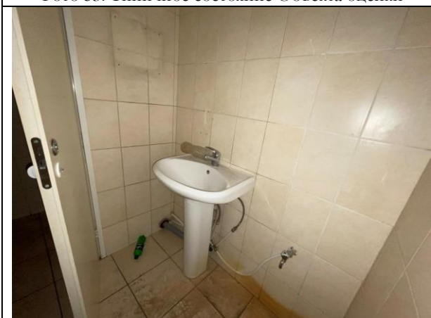
Фото 55. Типичное состояние Объекта оценки
