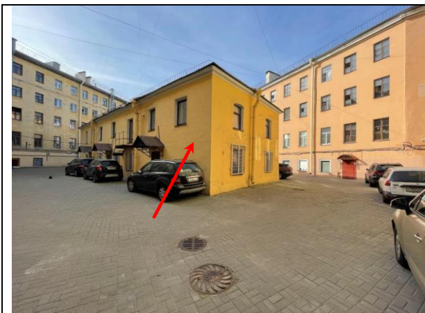
Фото 23. Вид здания расположения Объекта оценки
