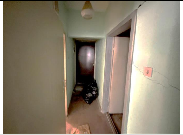
Фото 62. Типичное состояние Объекта оценки, входная группа Объекта оценки
