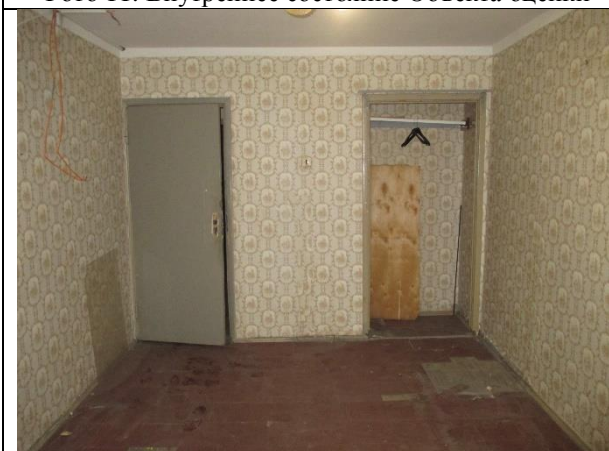
Фото 13. Внутреннее состояние Объекта оценки
