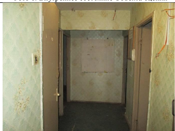
Фото 8. Вход Объекта оценки
