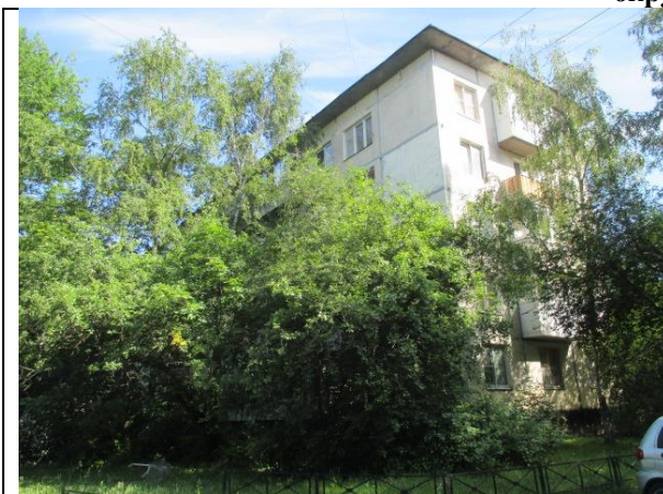
Фото 1. Вид здания, в котором расположен Объект оценки
