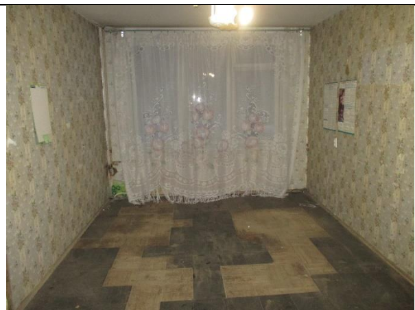
Фото 10. Внутреннее состояние Объекта оценки
