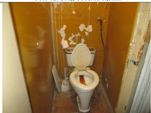
Фото 14. Внутреннее состояние Объекта оценки
