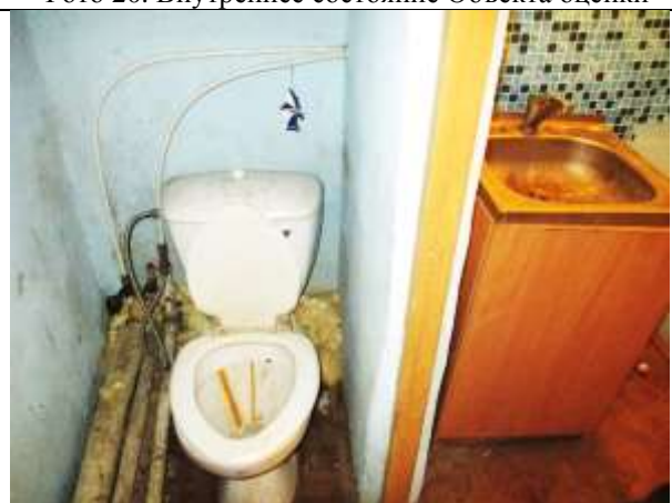
Фото 22. Внутреннее состояние Объекта оценки
