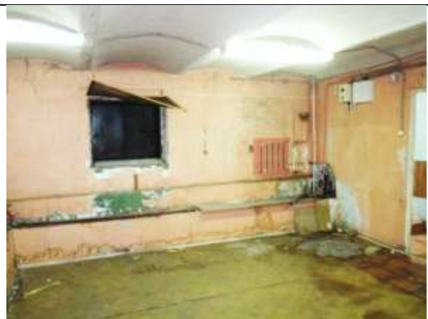
Фото 18. Внутреннее состояние Объекта оценки
