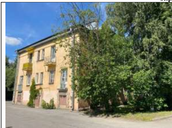
Фото 1. Вид здания, в котором расположен Объект оценки
