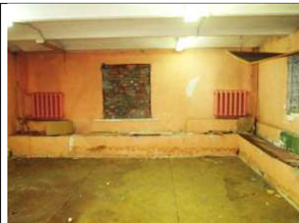
Фото 17. Внутреннее состояние Объекта оценки
