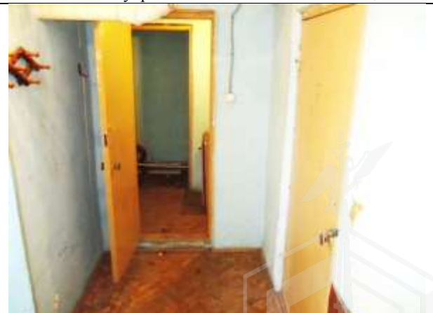
Фото 16. Внутреннее состояние Объекта оценки
