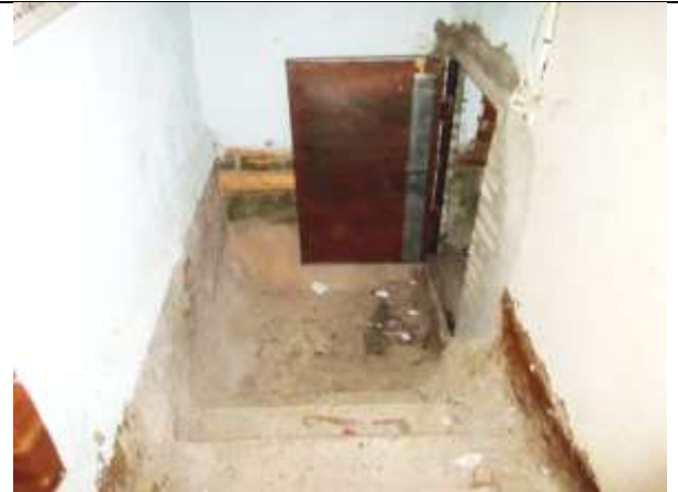
Фото 12. Внутреннее состояние Объекта оценки
