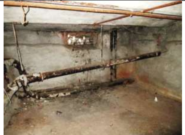
Фото 14. Внутреннее состояние Объекта оценки
