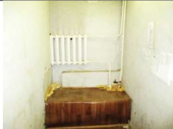
Фото 11. Внутреннее состояние Объекта оценки
