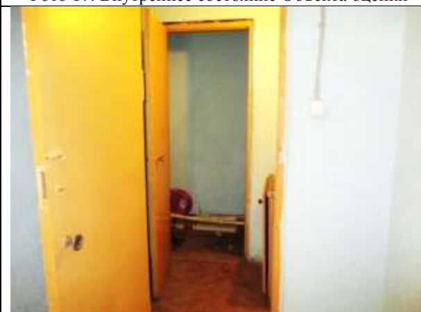
Фото 19. Внутреннее состояние Объекта оценки
