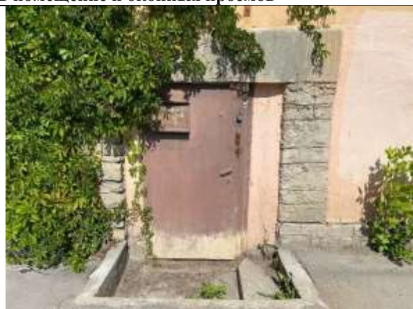
Фото 4. Вход Объекта оценки
