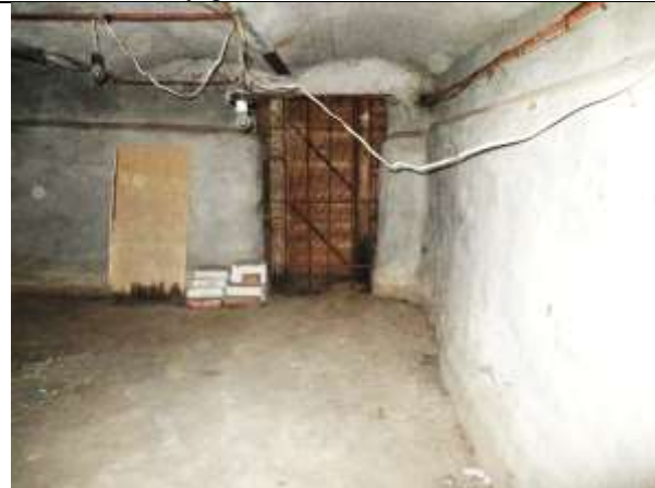
Фото 13. Внутреннее состояние Объекта оценки
