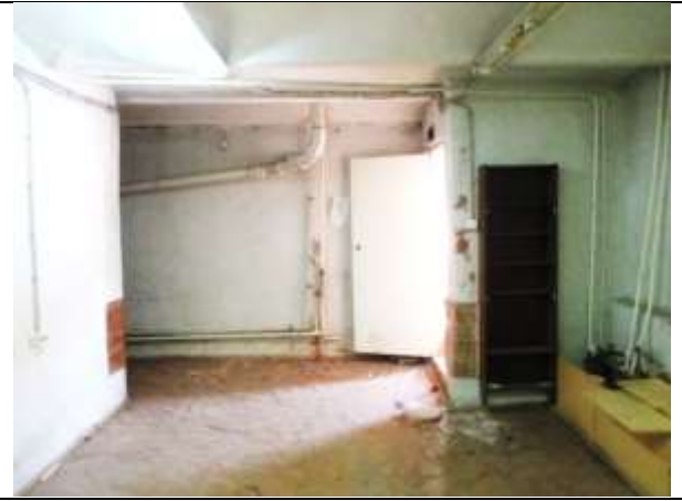
Фото 10. Внутреннее состояние Объекта оценки
