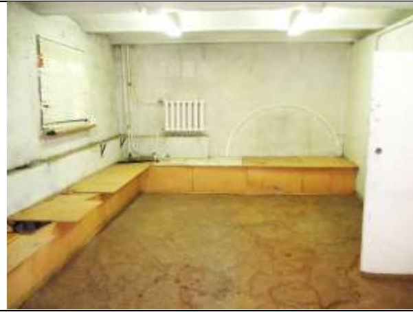
Фото 9. Внутреннее состояние Объекта оценки
