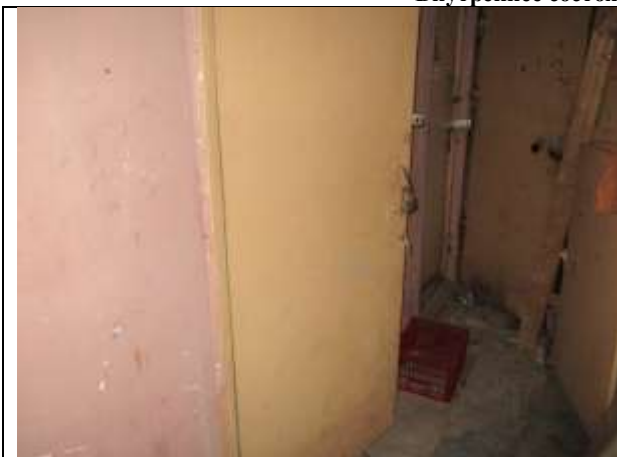
Фото 7. Внутреннее состояние Объекта оценки
