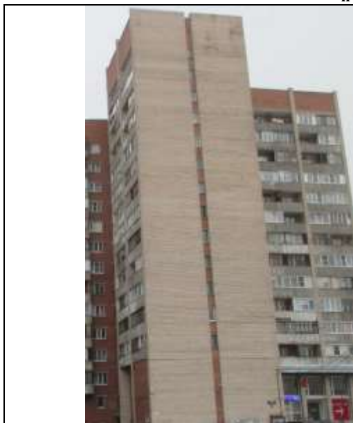
Фото 1. Вид здания, в котором расположен Объект оценки
