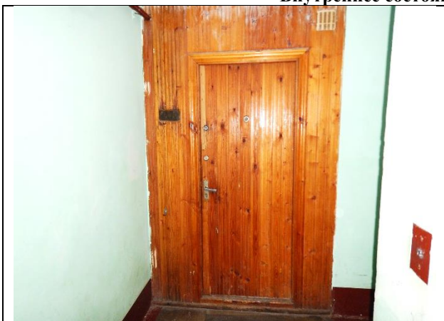
Фото 5. Внутреннее состояние Объекта оценки
