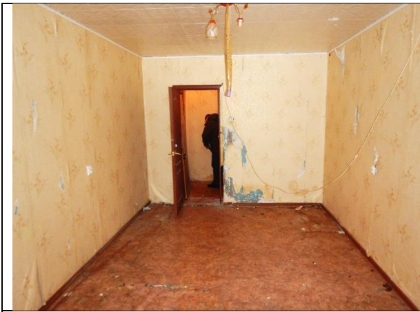
Фото 7. Внутреннее состояние Объекта оценки
