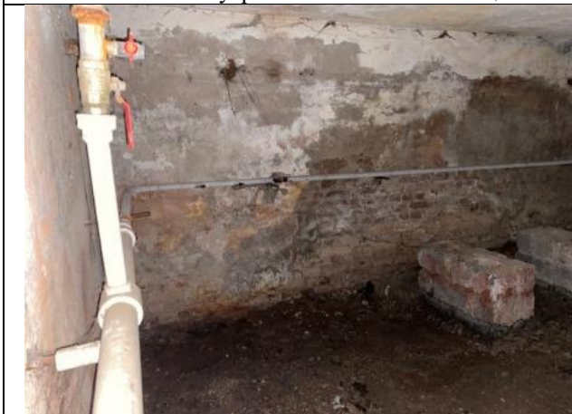
Фото № 41 – Внутреннее состояние помещения
