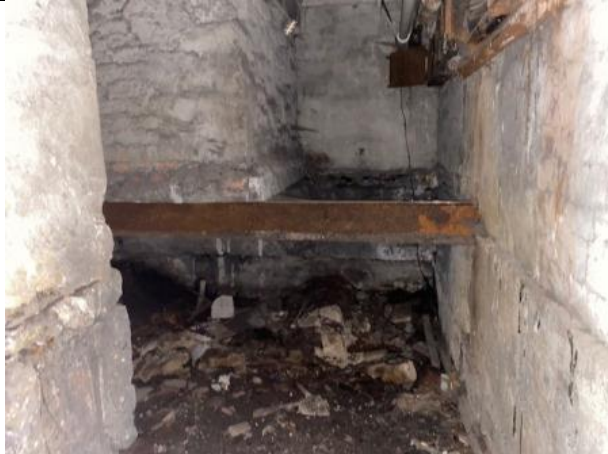
Фото № 25 – Внутреннее состояние помещения
