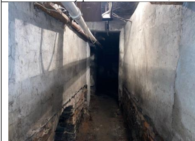
Фото № 13 – Внутреннее состояние помещения
