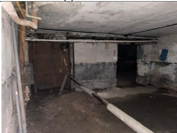
Фото № 19 – Внутреннее состояние помещения
