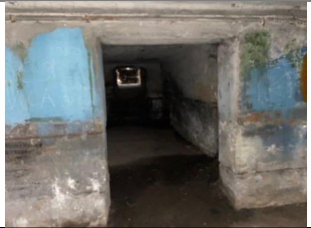
Фото № 24 – Внутреннее состояние помещения
