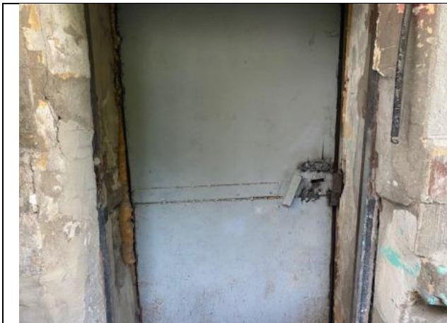
Фото № 7 – Вход в помещение
