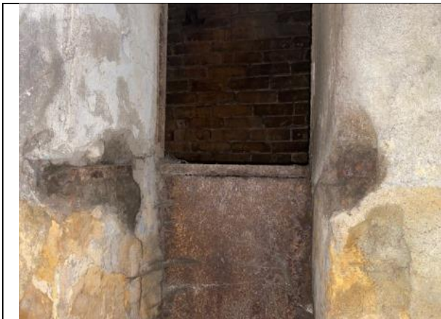
Фото № 39 – Внутреннее состояние помещения
