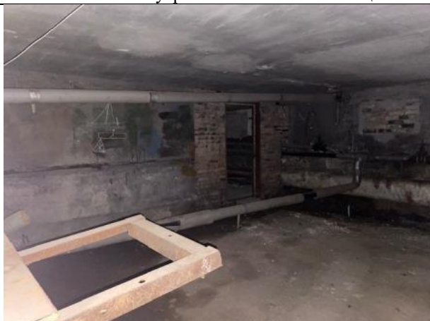
Фото № 21 – Внутреннее состояние помещения
