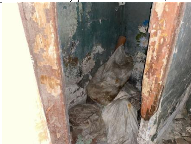
Фото № 12 – Внутреннее состояние помещения
