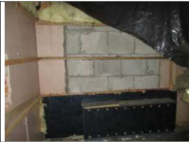
Фото 15. Внутреннее состояние Объекта оценки
