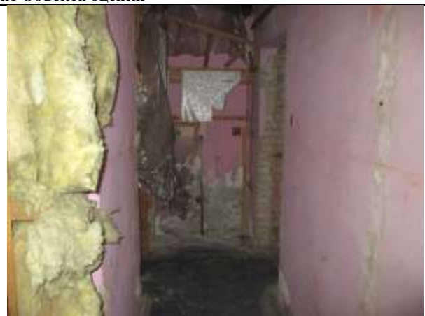
Фото 12. Внутреннее состояние Объекта оценки
