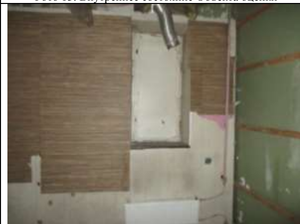
Фото 17. Внутреннее состояние Объекта оценки
