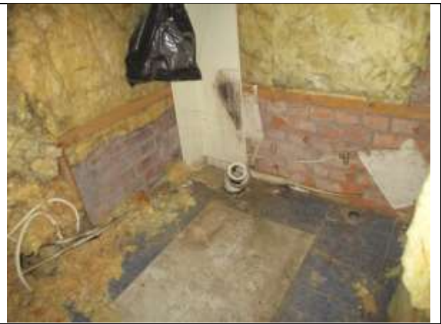
Фото 16. Внутреннее состояние Объекта оценки
