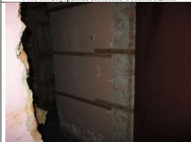
Фото 13. Внутреннее состояние Объекта оценки
