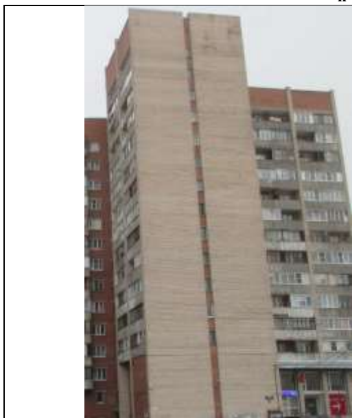
Фото 1. Вид здания, в котором расположен Объект оценки
