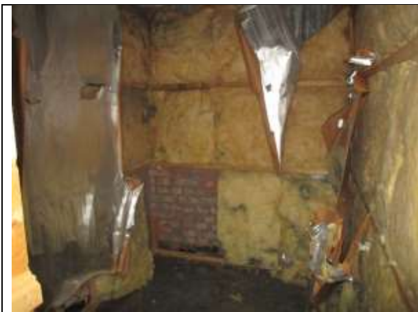
Фото 23. Внутреннее состояние Объекта оценки
