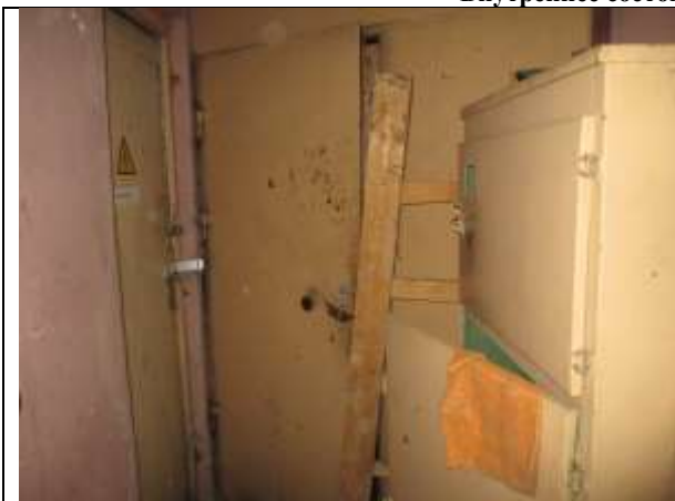
Фото 11. Внутреннее состояние Объекта оценки
