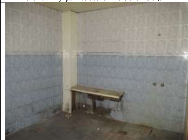
Фото 21. Внутреннее состояние Объекта оценки
