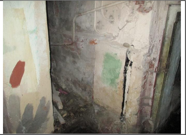
Фото 10. Внутреннее состояние Объекта оценки
