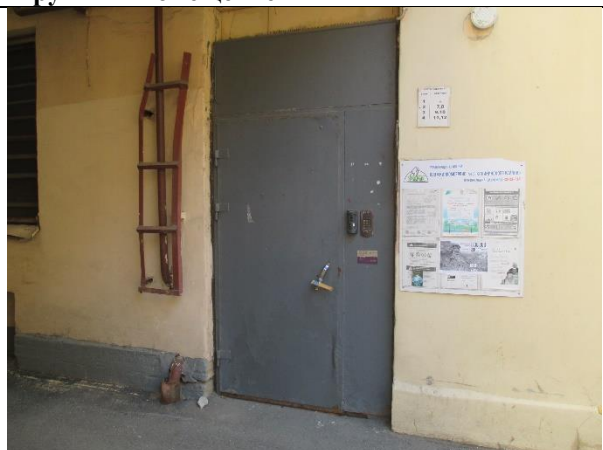
Фото 6. Общий вход со двора (из арки)
