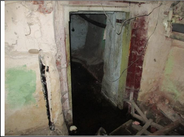
Фото 9. Внутреннее состояние Объекта оценки
