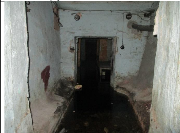
Фото 11. Внутреннее состояние Объекта оценки
