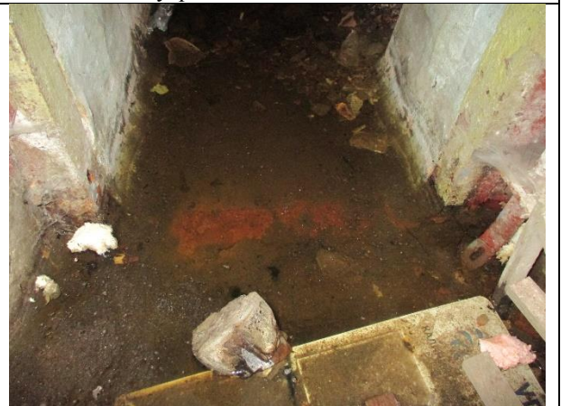
Фото 12. Внутреннее состояние Объекта оценки
