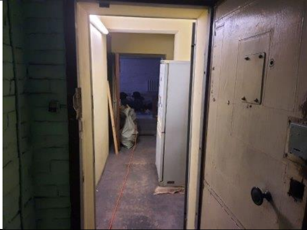
Фото № 9 – Внутреннее состояние помещения
