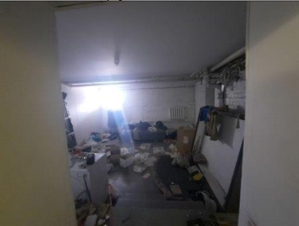
Фото № 19 – Внутреннее состояние помещения
