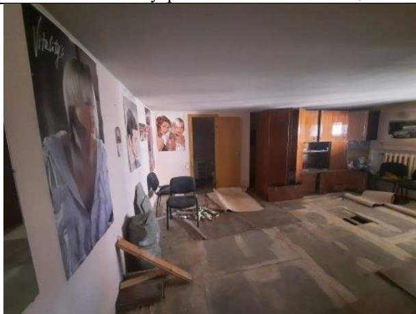
Фото № 11 – Внутреннее состояние помещения
