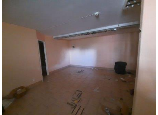
Фото № 18 – Внутреннее состояние помещения
