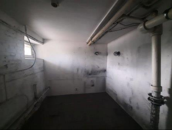
Фото № 15 – Внутреннее состояние помещения
