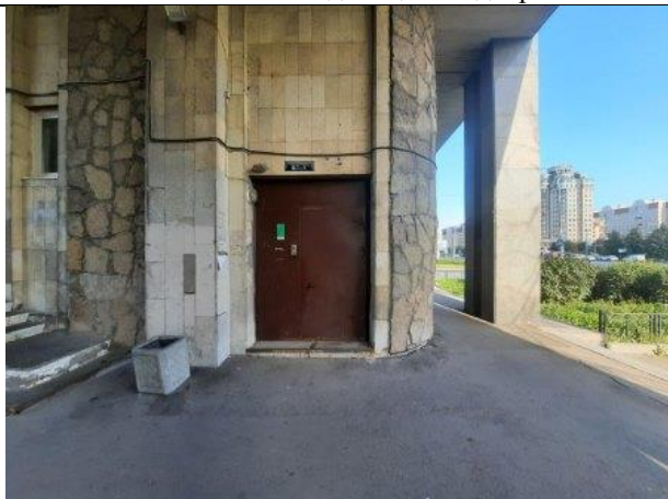
Фото № 7 – Общий вход из-под арки
