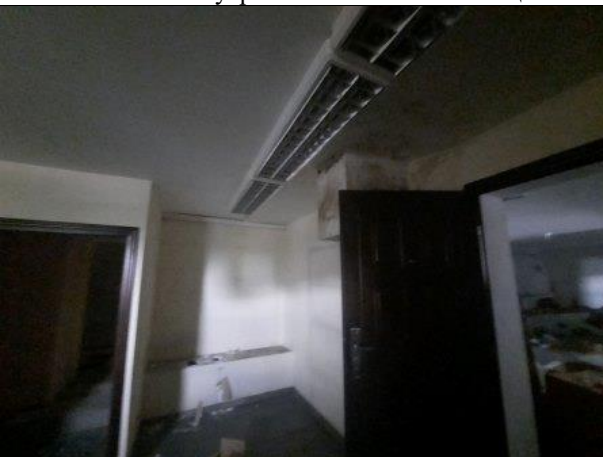
Фото № 21 – Внутреннее состояние помещения
