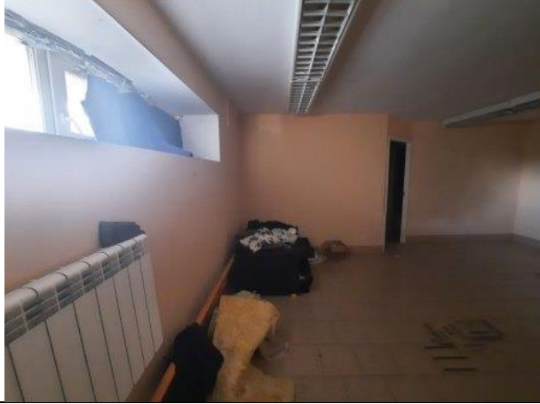
Фото № 11 – Внутреннее состояние помещения
