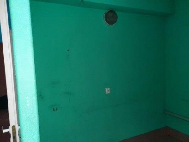
Фото № 17 – Внутреннее состояние помещения
