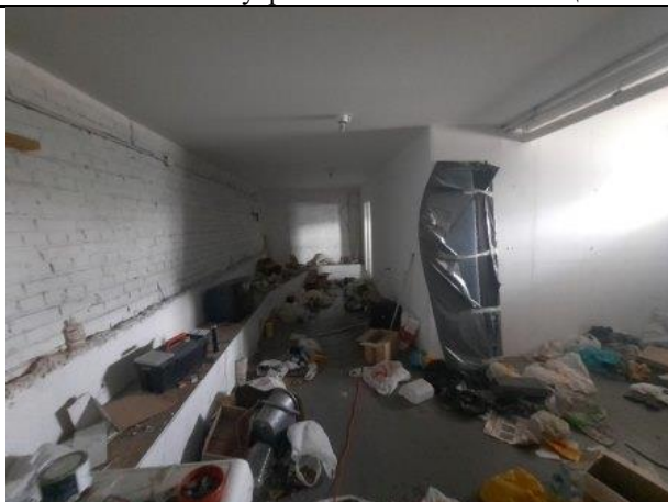
Фото № 13 – Внутреннее состояние помещения
