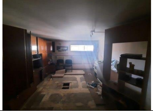
Фото № 12 – Внутреннее состояние помещения
