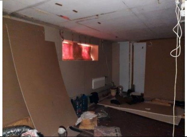
Фото № 16 – Внутреннее состояние помещения
