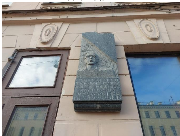
Фото 3. Вид здания, в котором расположен Объект оценки
