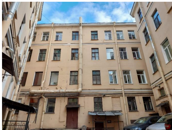
Фото 2. Вид здания, в котором расположен Объект оценки
