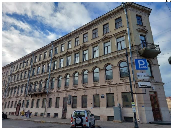
Фото 1. Вид здания, в котором расположен Объект оценки
