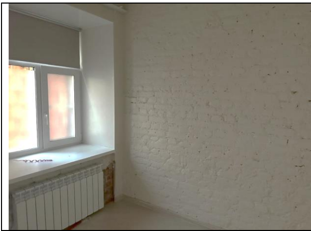
Фото 15. Типичное состояние Объекта оценки
