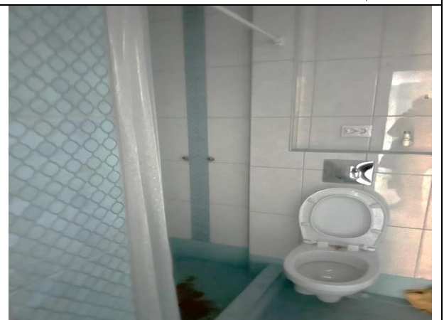
Фото 20. Типичное состояние Объекта оценки
