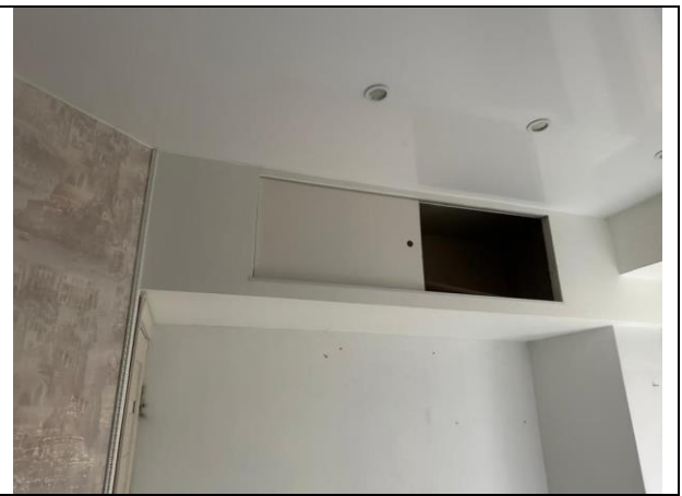
Фото 16. Типичное состояние Объекта оценки
