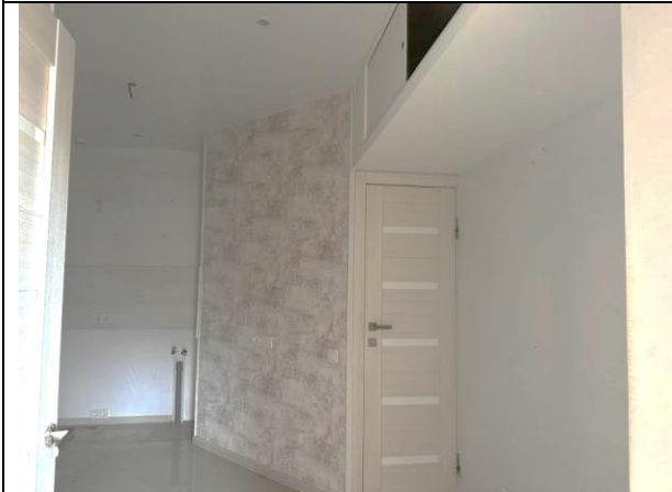
Фото 17. Типичное состояние Объекта оценки
