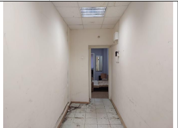
Фото 10. Внутреннее состояние Объекта оценки
