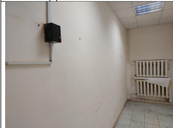
Фото 11. Внутреннее состояние Объекта оценки
