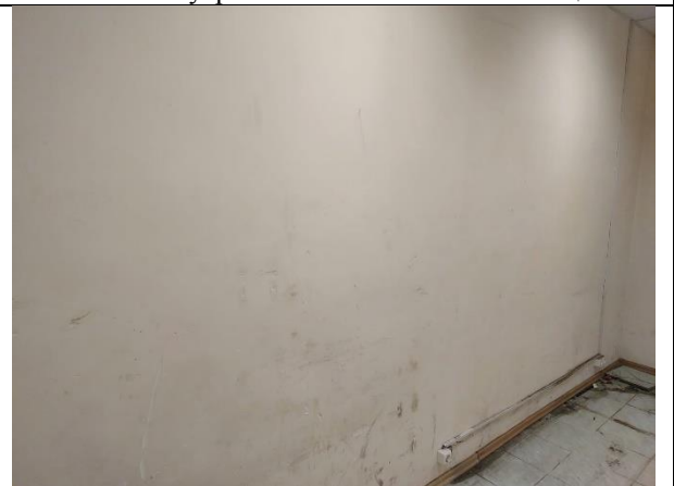
Фото 12. Внутреннее состояние Объекта оценки
