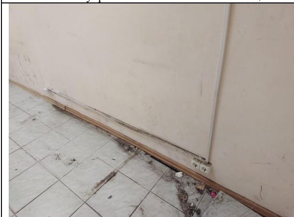
Фото 13. Внутреннее состояние Объекта оценки
