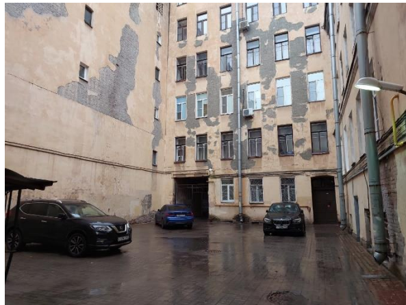
Фото 2. Вид здания, в котором расположен Объект оценки. Дворовая территория
