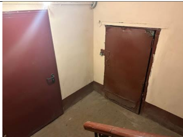
Фото № 6 – Вход в помещение
