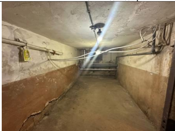
Фото № 7 – Внутреннее состояние помещения
