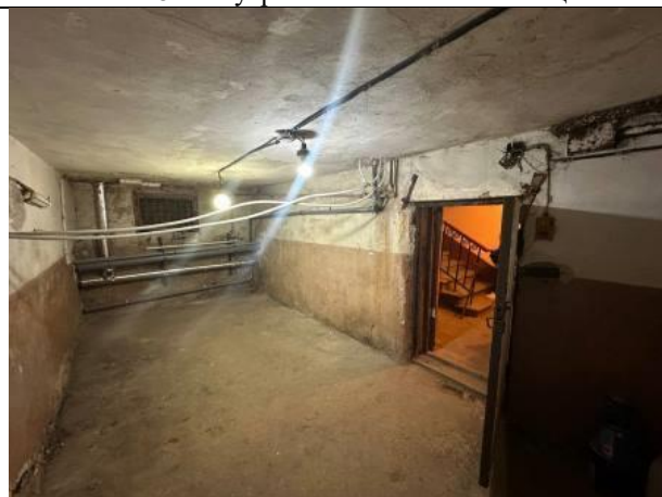
Фото № 10 – Внутреннее состояние помещения
