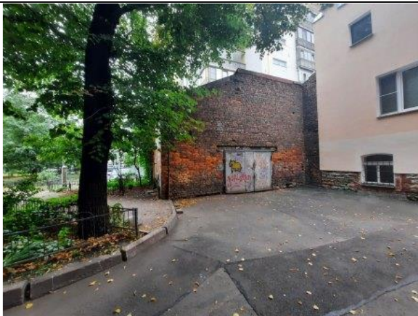
Фото № 7. Внешний вид здания
