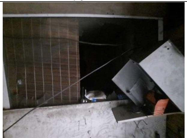
Фото № 16. Внутреннее состояние здания
