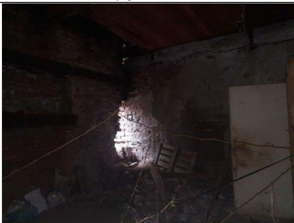
Фото № 15. Внутреннее состояние здания
