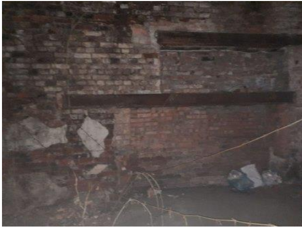
Фото № 13. Внутреннее состояние здания
