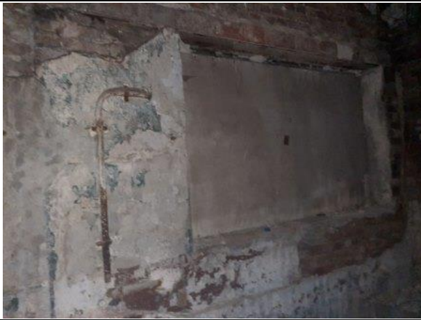
Фото № 11. Внутреннее состояние здания
