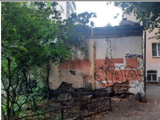
Фото № 9. Внутреннее состояние здания
