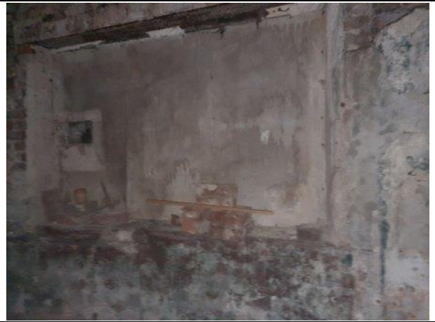
Фото № 12. Внутреннее состояние здания
