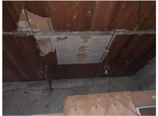
Фото № 14. Внутреннее состояние здания
