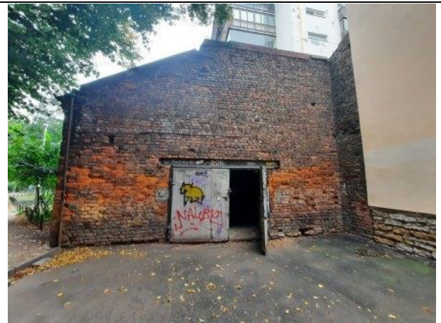
Фото № 8. Внешний вид здания
