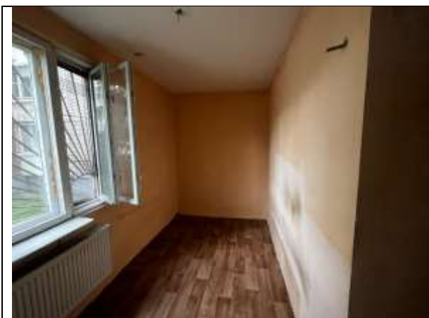
Фото 7. Внутреннее состояние Объекта оценки
