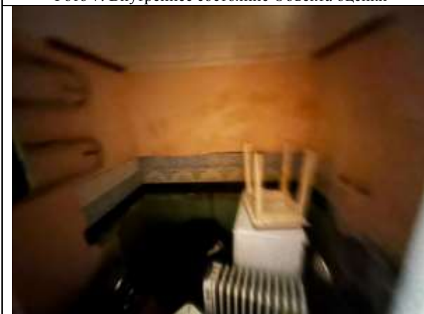
Фото 9. Внутреннее состояние Объекта оценки
