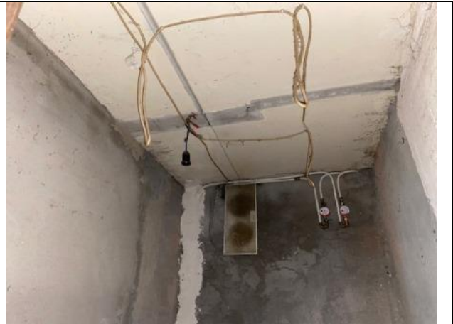
Фото № 14 – Внутреннее состояние помещения
