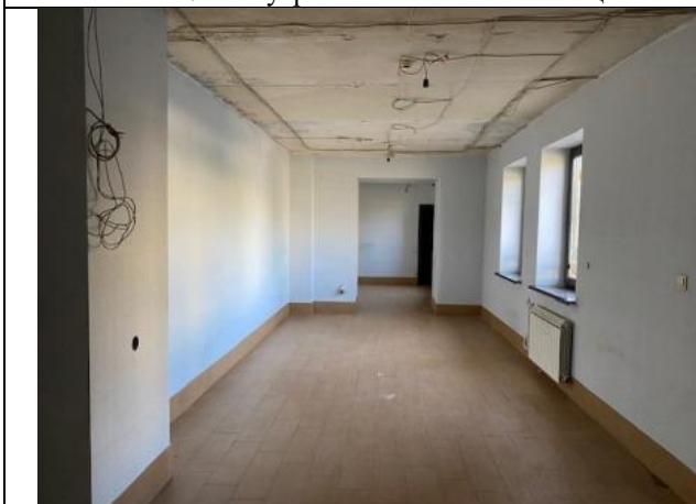
Фото № 9 – Внутреннее состояние помещения
