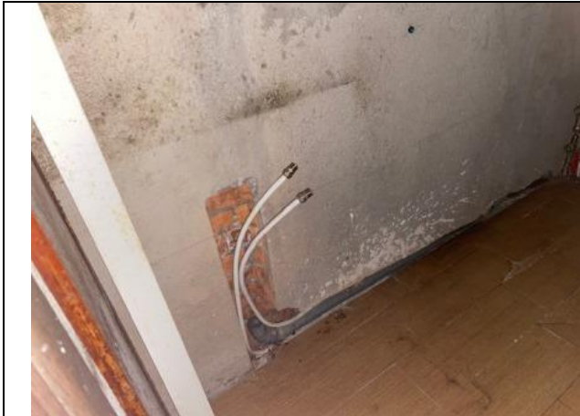
Фото № 13 – Внутреннее состояние помещения
