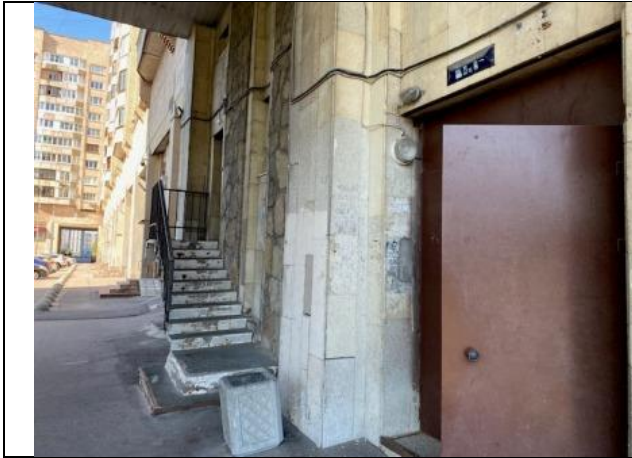
Фото № 5 – Общий вход со двора
