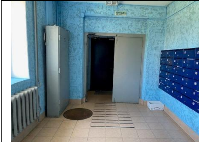
Фото № 7 – Внутреннее состояние помещения
