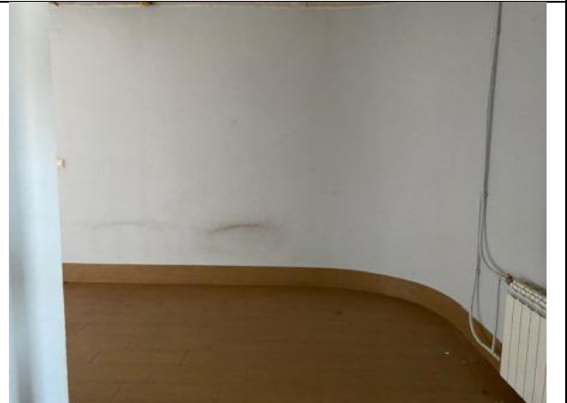
Фото № 8 – Внутреннее состояние помещения
