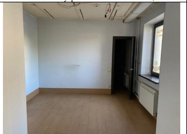
Фото № 10 – Внутреннее состояние помещения
