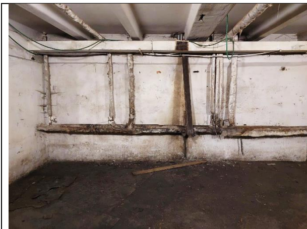
Фото 7. Внутреннее состояние Объекта оценки
