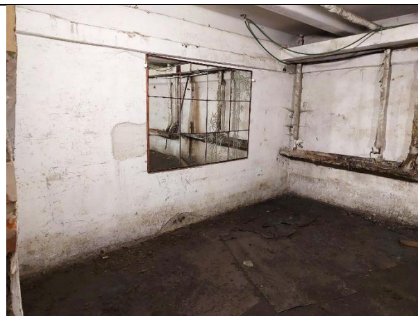
Фото 8. Внутреннее состояние Объекта оценки
