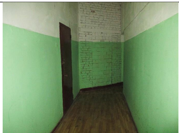
Фото 18. Внутреннее состояние Объекта оценки
