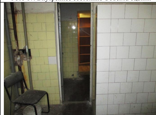
Фото 19. Внутреннее состояние Объекта оценки
