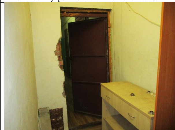
Фото 15. Внутреннее состояние Объекта оценки
