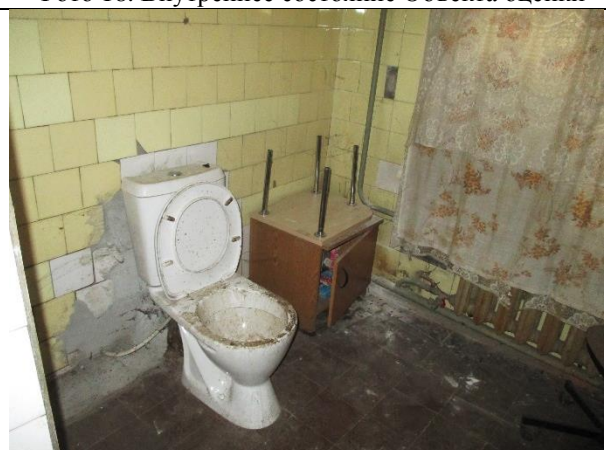
Фото 20. Внутреннее состояние Объекта оценки
