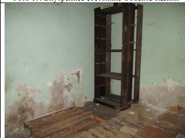
Фото 21. Внутреннее состояние Объекта оценки
