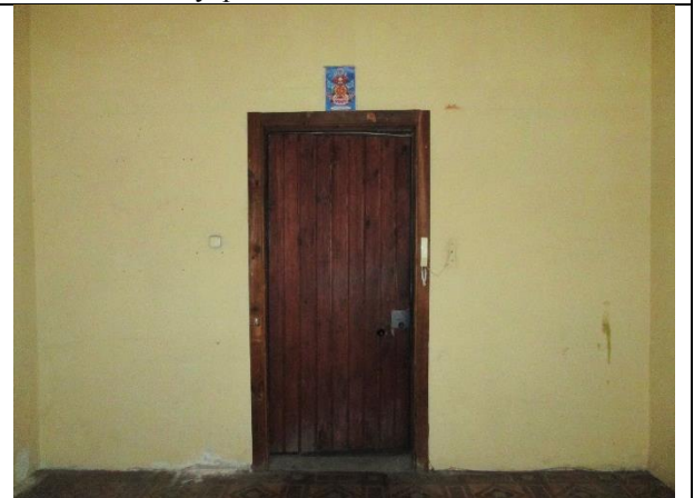
Фото 12. Внутреннее состояние Объекта оценки
