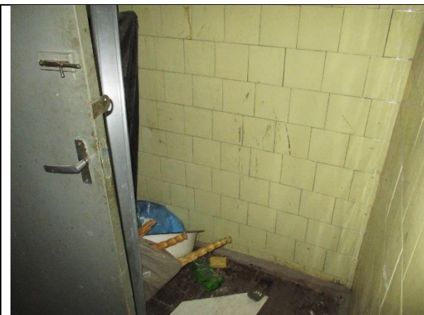
Фото 17. Внутреннее состояние Объекта оценки
