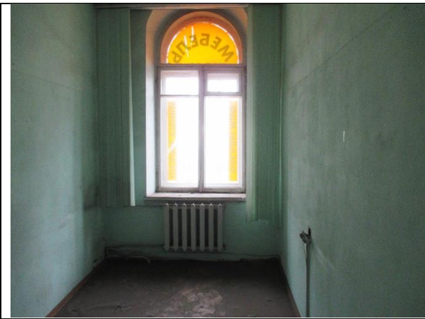
Фото 9. Внутреннее состояние Объекта оценки
