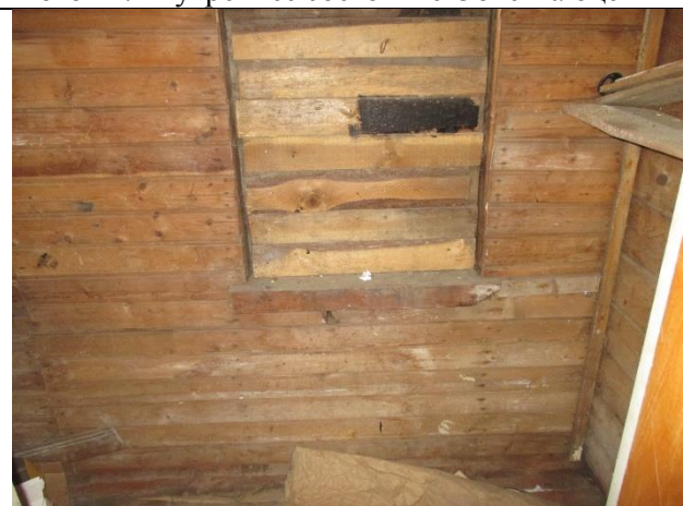
Фото 14. Внутреннее состояние Объекта оценки
