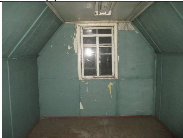
Фото 30. Внутреннее состояние Объекта оценки
