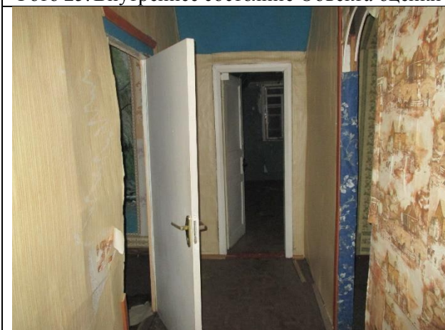
Фото 27. Внутреннее состояние Объекта оценки
