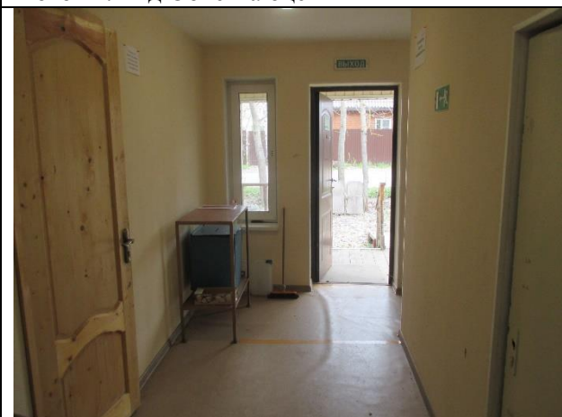
Фото 13. Внутреннее состояние Объекта оценки
