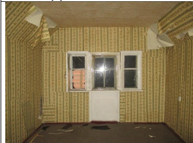
Фото 29. Внутреннее состояние Объекта оценки
