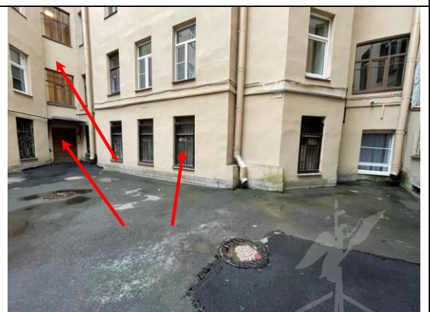
Фото 30. Вид здания расположения Объекта оценки, входная и оконная группа Объекта оценки (посмотреть оконную группу по плану)
