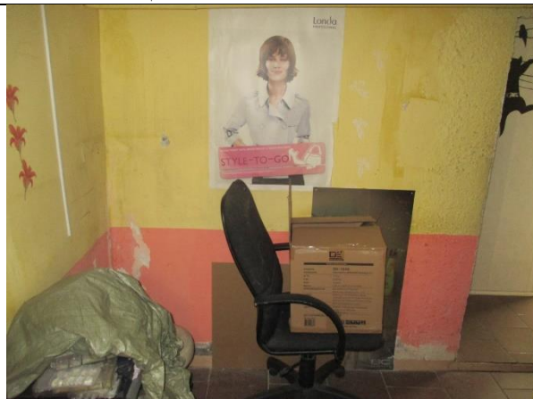
Фото 8. Внутреннее состояние Объекта оценки
