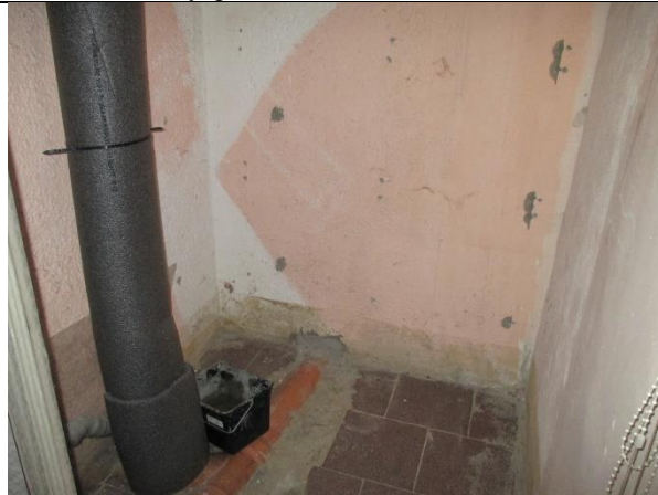
Фото 12. Внутреннее состояние Объекта оценки
