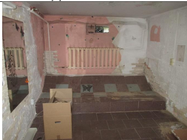
Фото 10. Внутреннее состояние Объекта оценки
