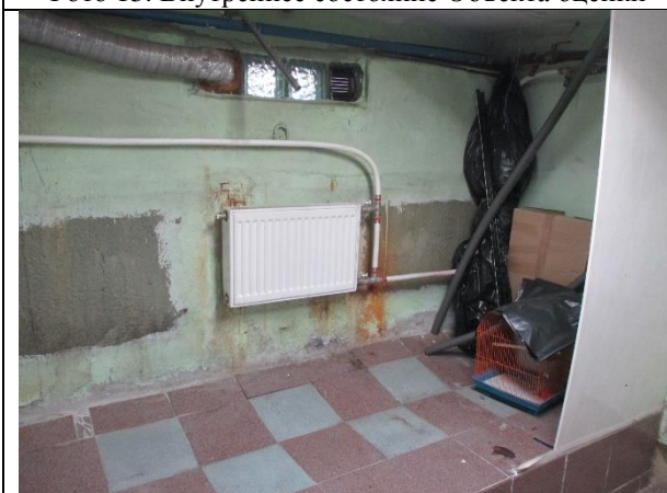
Фото 15. Внутреннее состояние Объекта оценки
