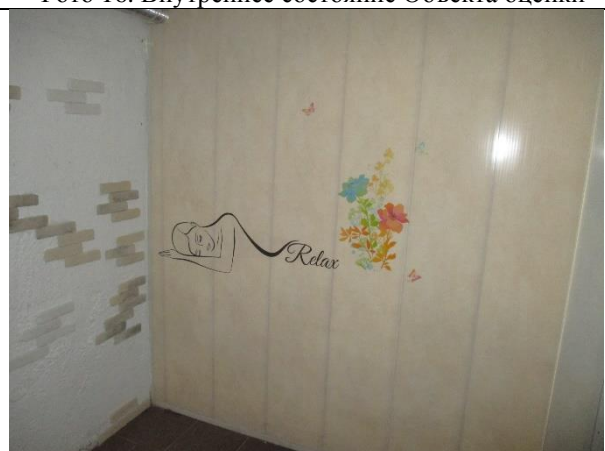
Фото 18. Внутреннее состояние Объекта оценки
