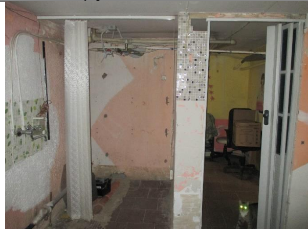
Фото 11. Внутреннее состояние Объекта оценки
