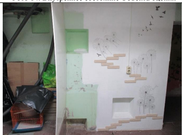
Фото 16. Внутреннее состояние Объекта оценки
