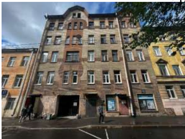
Фото 1. Вид здания, в котором расположен Объект оценки
