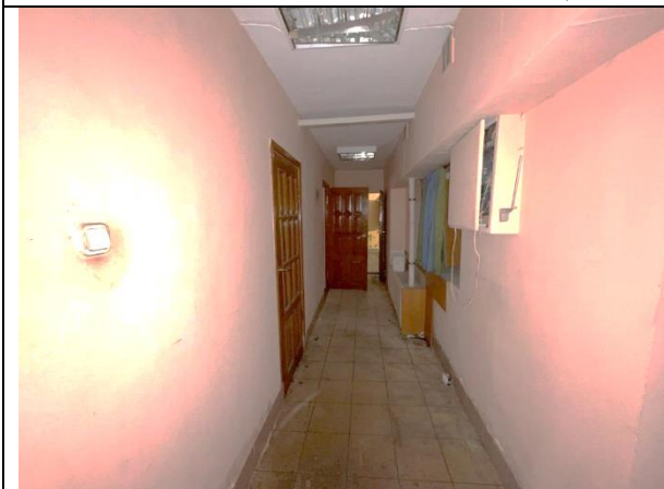
Фото 19. Типичное состояние Объекта оценки
