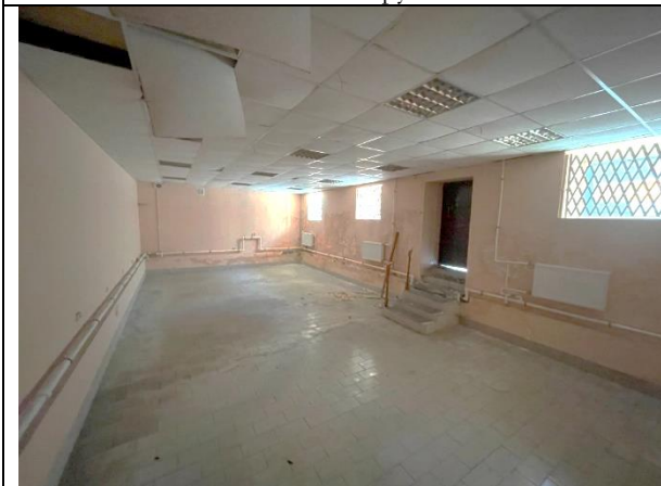
Фото 27. Типичное состояние Объекта оценки
