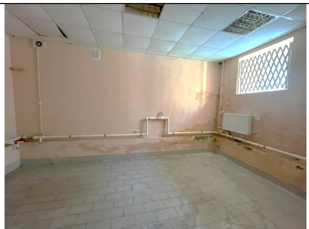
Фото 26. Типичное состояние Объекта оценки
