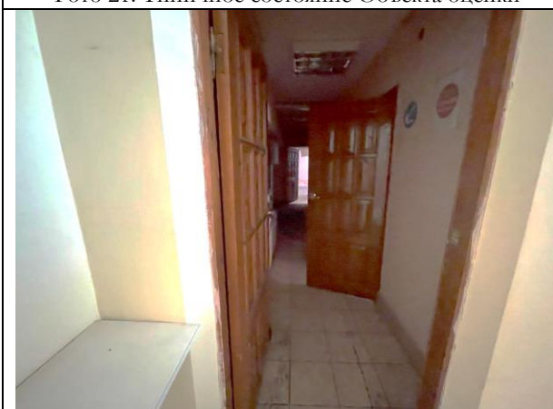
Фото 23. Типичное состояние Объекта оценки
