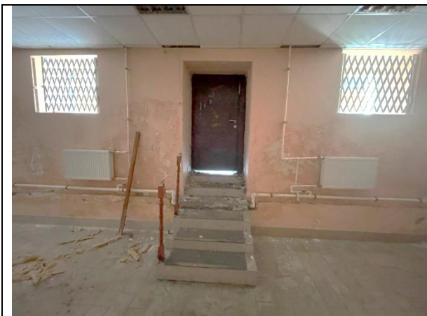
Фото 25. Входная и оконная группа Объекта оценки
