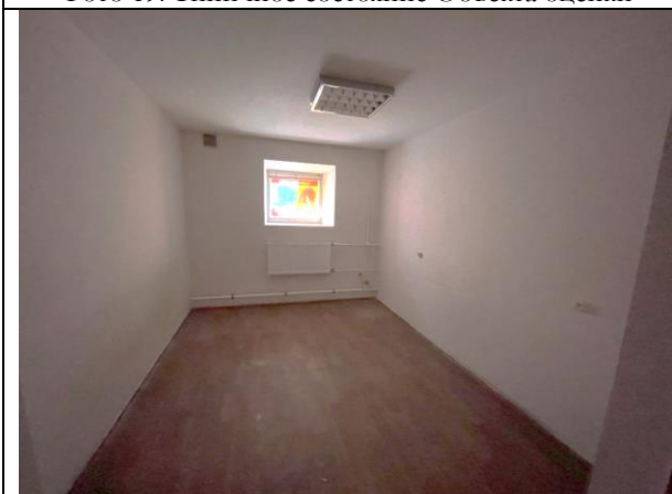
Фото 21. Типичное состояние Объекта оценки
