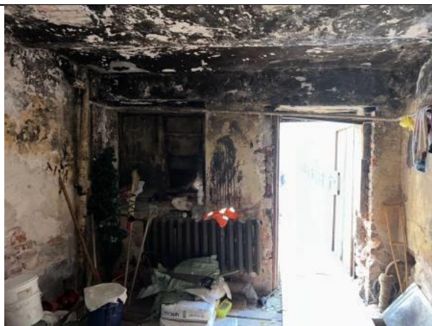
Фото № 16 – Внутреннее состояние помещения
