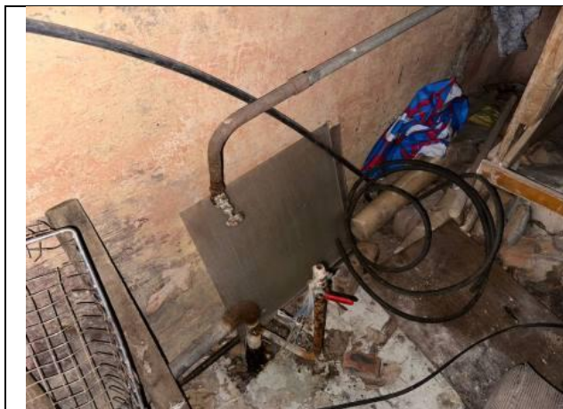
Фото № 15 – Внутреннее состояние помещения
