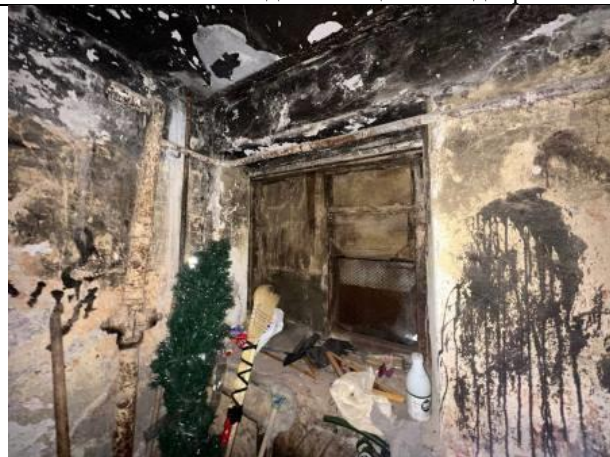
Фото № 10 – Внутреннее состояние помещения
