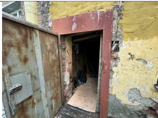
Фото № 8 – Вход в помещение со двора
