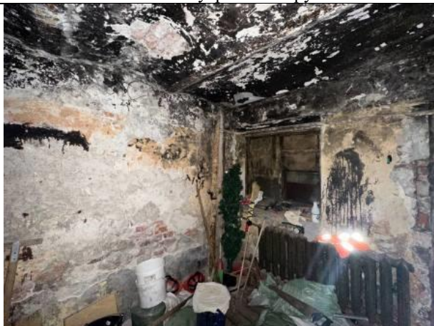
Фото № 9 – Внутреннее состояние помещения
