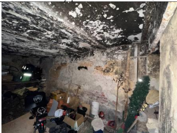
Фото № 13 – Внутреннее состояние помещения
