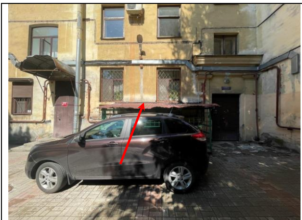
Фото 21. Вид здания расположения Объекта оценки
