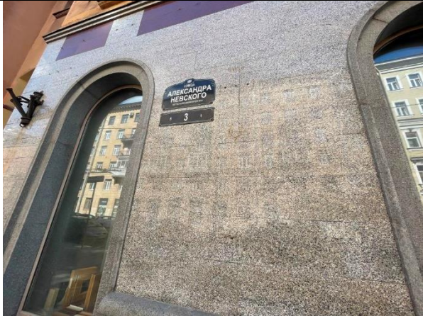
Фото 15. Адрес Объекта оценки
