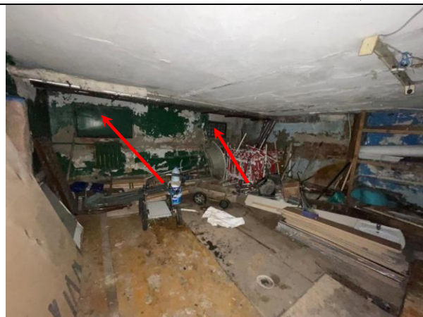
Фото 32. Типичное состояние Объекта оценки, оконная группа Объекта оценки
