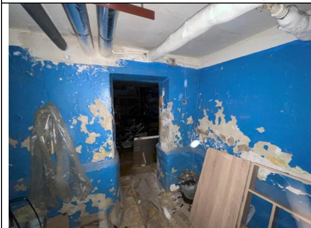
Фото 35. Типичное состояние Объекта оценки
