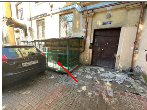
Фото 22. Вид здания расположения Объекта оценки
