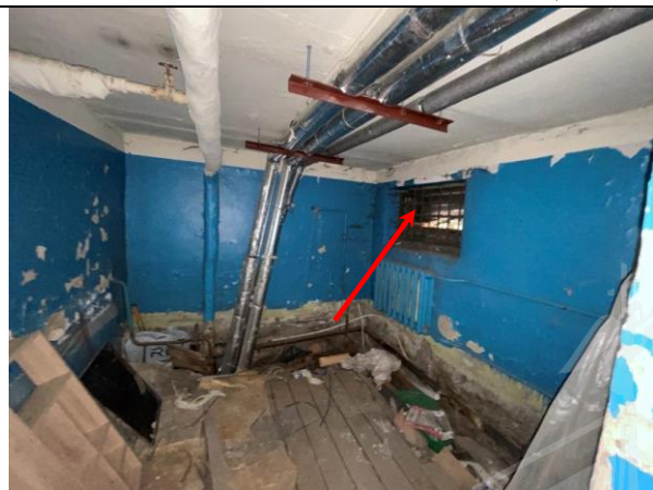
Фото 36. Типичное состояние Объекта оценки, оконная группа Объекта оценки
