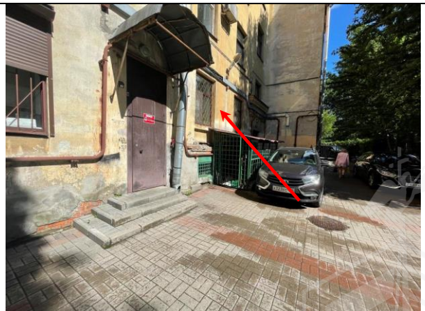
Фото 20. Вид здания расположения Объекта оценки
