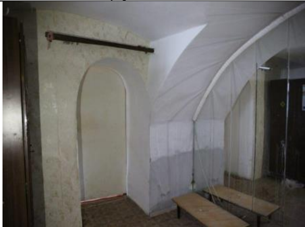
Фото № 25 – Внутреннее состояние помещения
