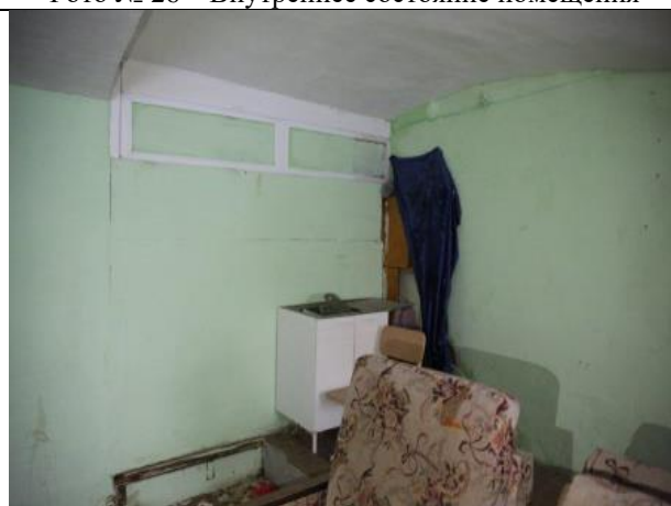
Фото № 28 – Внутреннее состояние помещения
