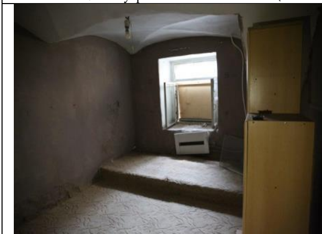
Фото № 19 – Внутреннее состояние помещения
