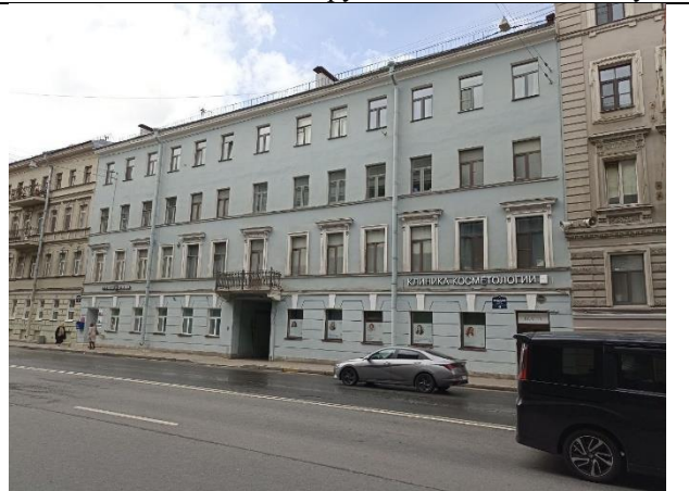
Фото № 4 – Внешний вид здания, в котором расположен объект оценки
