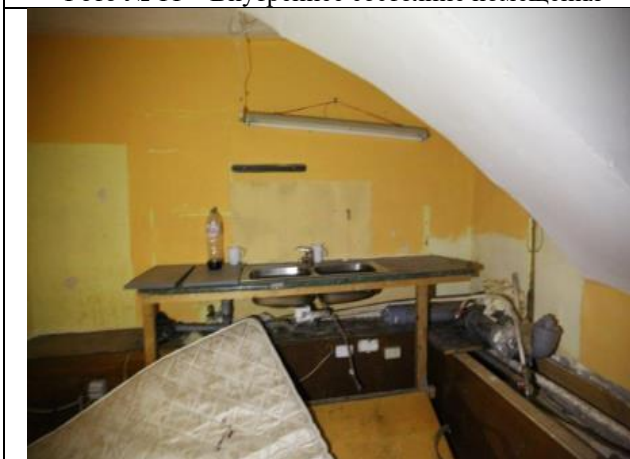
Фото № 13 – Внутреннее состояние помещения
