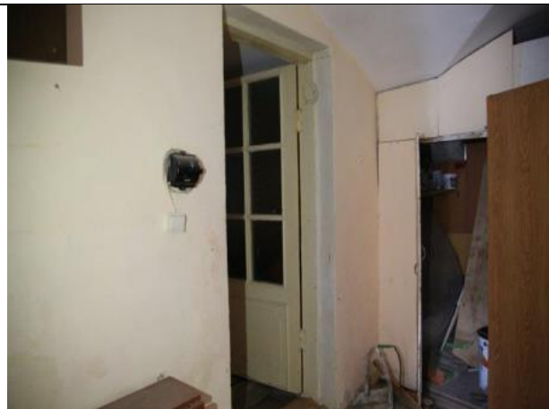
Фото № 8 – Внутреннее состояние помещения
