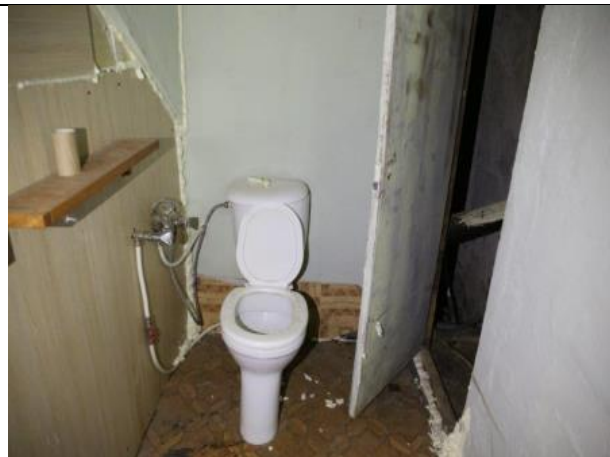
Фото № 16 – Внутреннее состояние помещения
