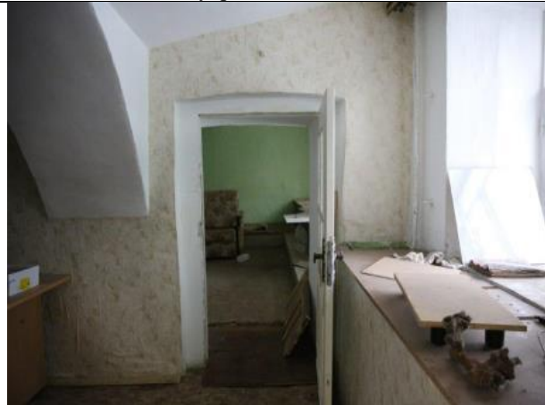
Фото № 26 – Внутреннее состояние помещения
