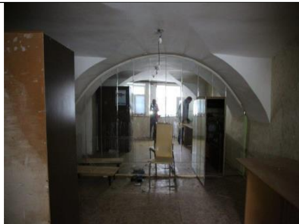
Фото № 24 – Внутреннее состояние помещения
