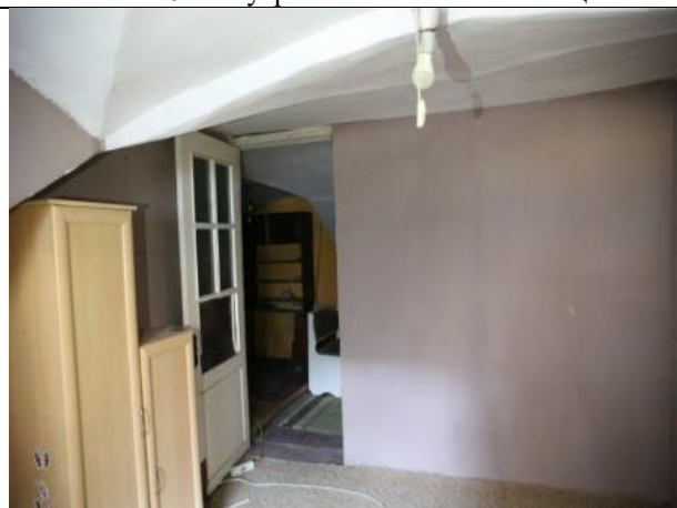
Фото № 20 – Внутреннее состояние помещения
