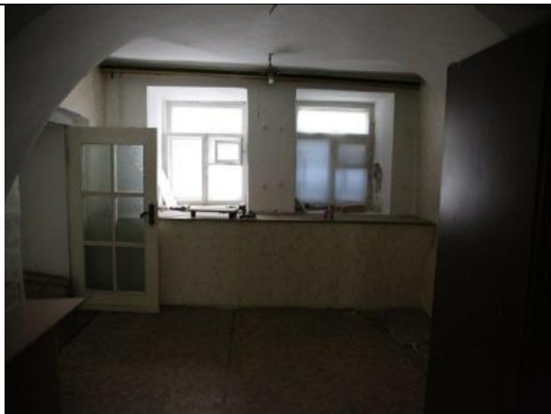
Фото № 23 – Внутреннее состояние помещения
