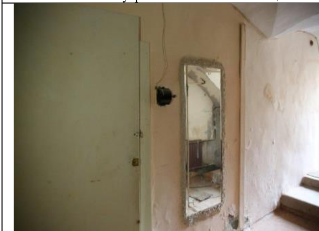
Фото № 21 – Внутреннее состояние помещения
