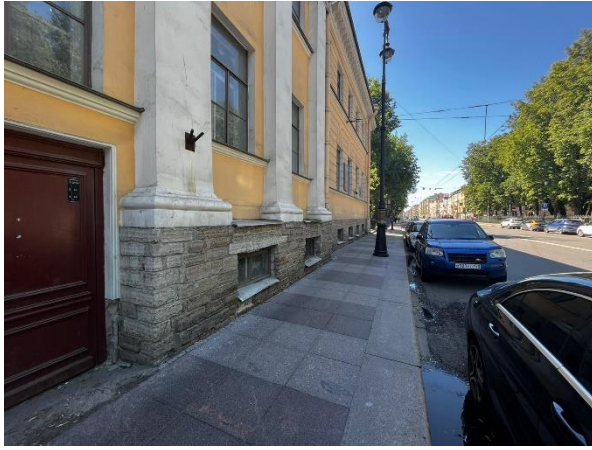
Фото 3. Вид здания Объекта оценки
