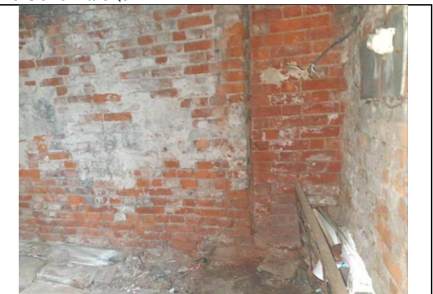
Фото 8. Внутреннее состояние Объекта оценки
