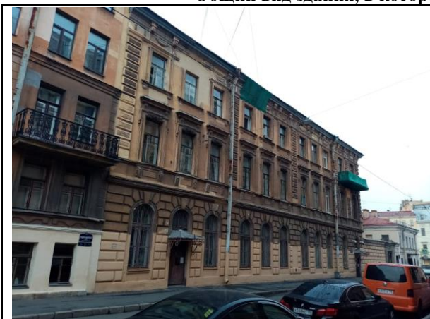
Фото 1. Вид здания, в котором расположен Объект оценки
