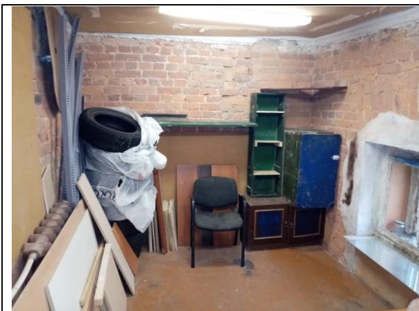
Фото 11. Внутреннее состояние Объекта оценки
