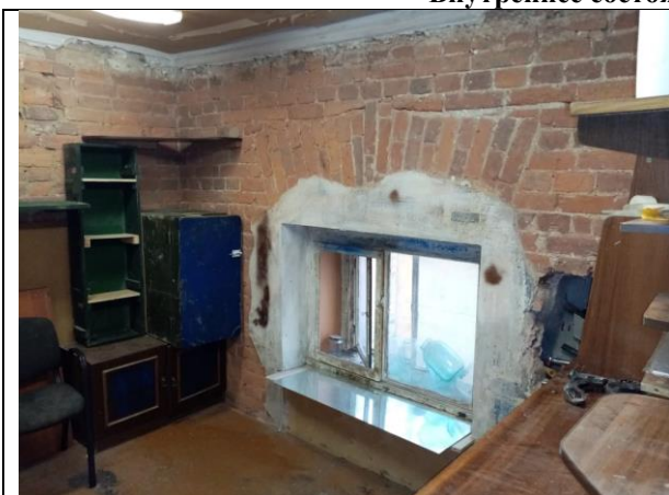
Фото 9. Внутреннее состояние Объекта оценки
