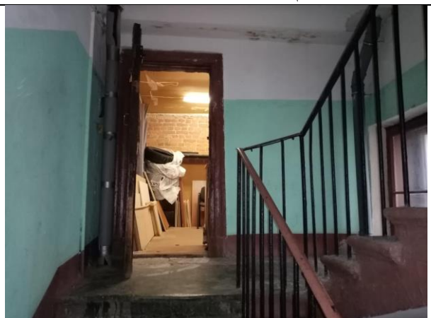
Фото 8. Вход Объекта оценки
