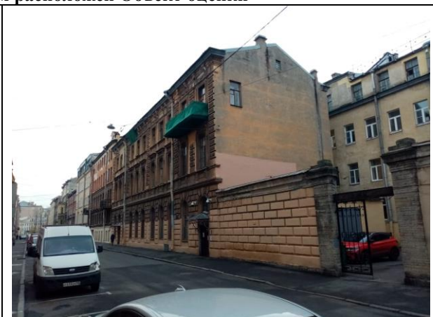
Фото 2. Вид здания, в котором расположен Объект оценки
