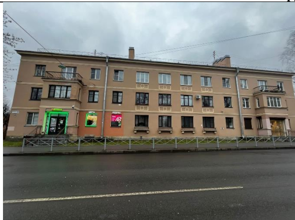
Фото 1. Вид здания, в котором расположен Объект оценки
