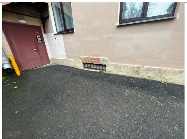
Фото 8. Вид окна Объекта оценки
