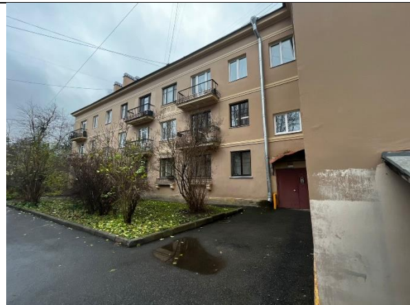
Фото 2. Вид здания, в котором расположен Объект оценки
