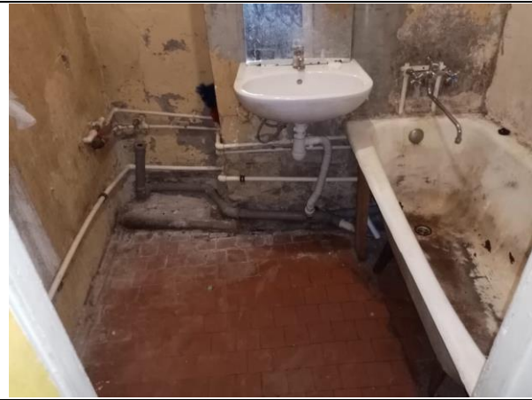
Фото 17. Внутреннее состояние Объекта оценки
