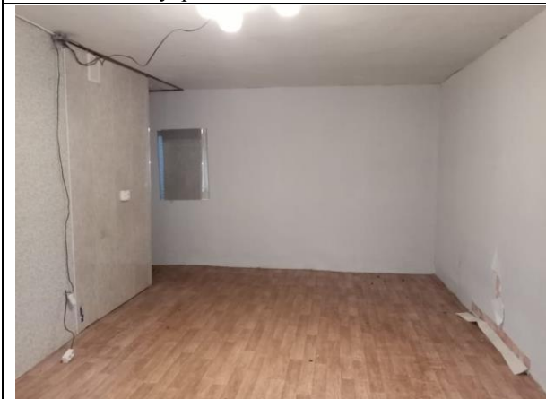
Фото 27. Внутреннее состояние Объекта оценки
