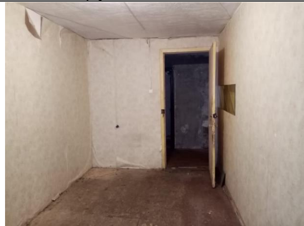
Фото 21. Внутреннее состояние Объекта оценки
