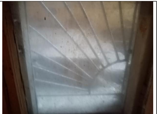
Фото 8. Внутреннее состояние Объекта оценки
