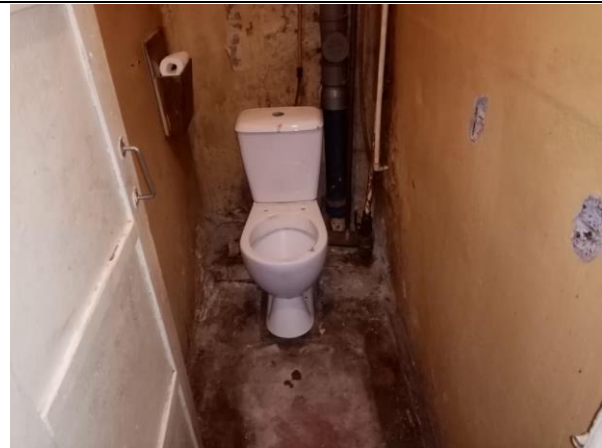
Фото 19. Внутреннее состояние Объекта оценки
