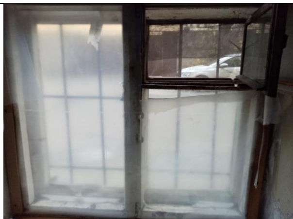
Фото 26. Внутреннее состояние Объекта оценки
