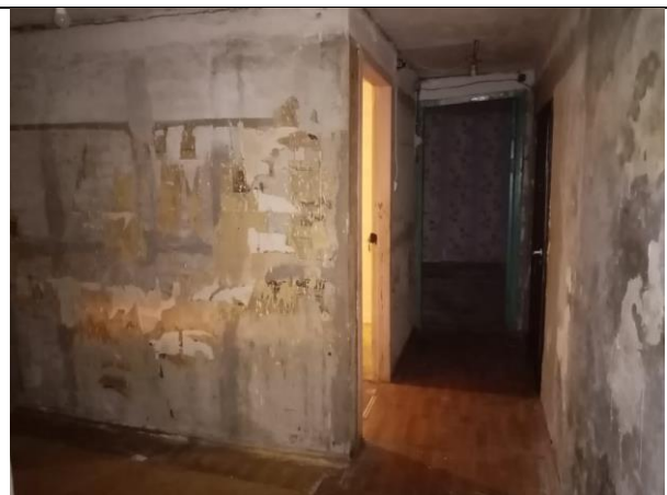
Фото 10. Внутреннее состояние Объекта оценки
