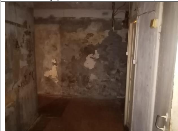
Фото 11. Внутреннее состояние Объекта оценки
