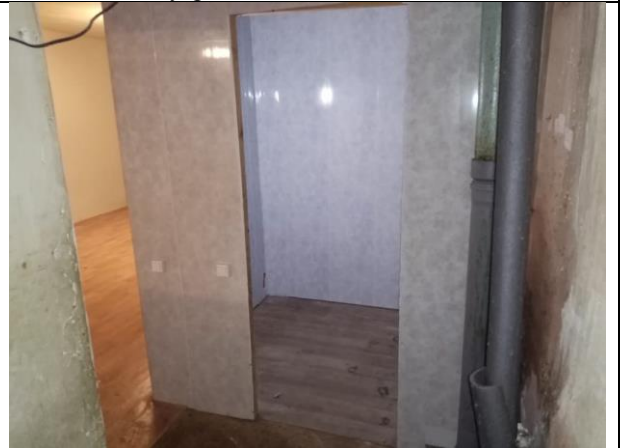
Фото 22. Внутреннее состояние Объекта оценки
