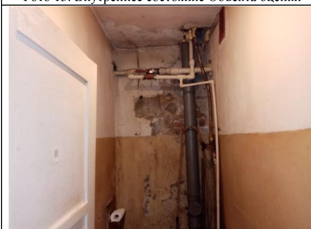
Фото 15. Внутреннее состояние Объекта оценки
