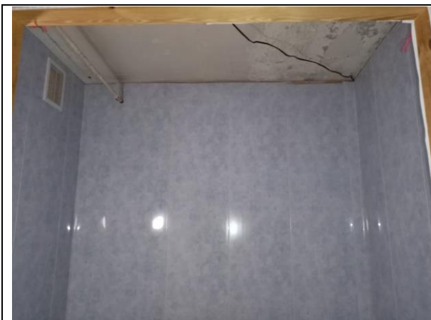
Фото 25. Внутреннее состояние Объекта оценки
