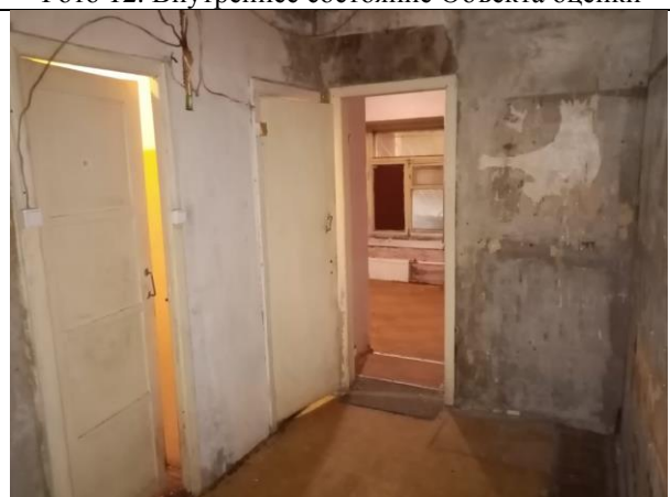
Фото 14. Внутреннее состояние Объекта оценки
