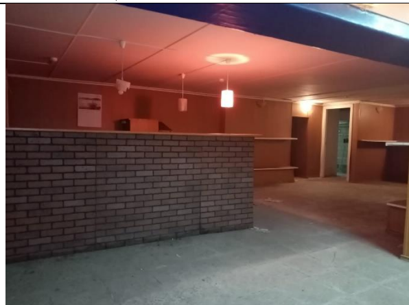
Фото 8. Внутреннее состояние Объекта оценки
