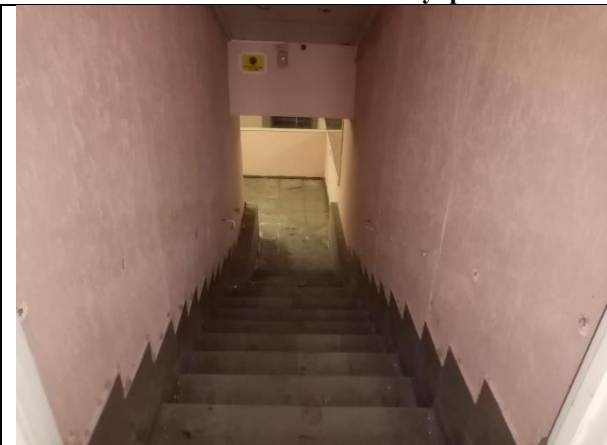
Фото 7. Внутреннее состояние Объекта оценки
