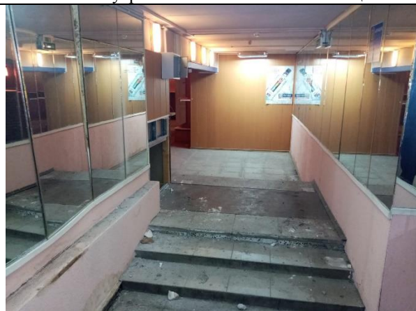
Фото 10. Внутреннее состояние Объекта оценки
