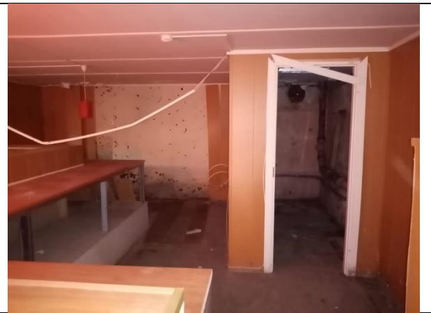
Фото 16. Внутреннее состояние Объекта оценки
