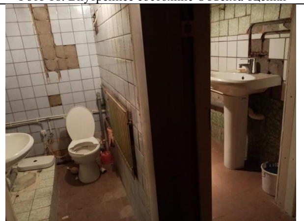
Фото 20. Внутреннее состояние Объекта оценки
