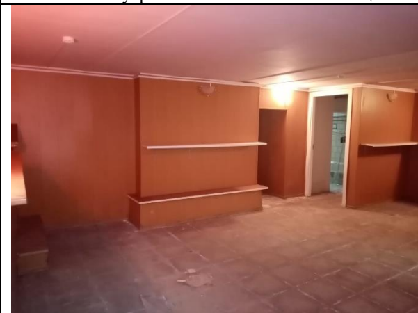
Фото 17. Внутреннее состояние Объекта оценки
