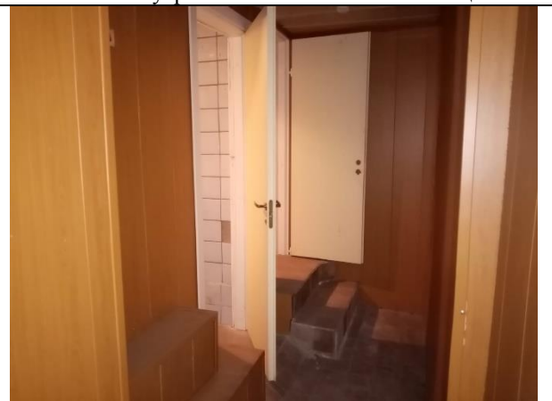
Фото 18. Внутреннее состояние Объекта оценки
