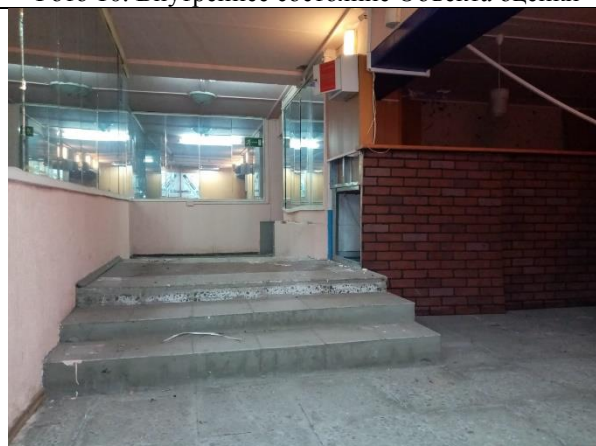
Фото 12. Внутреннее состояние Объекта оценки
