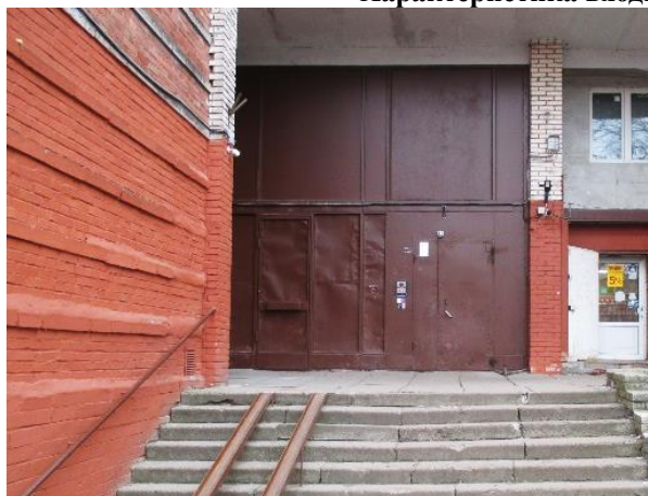
Фото 3. Общий вход с улицы
