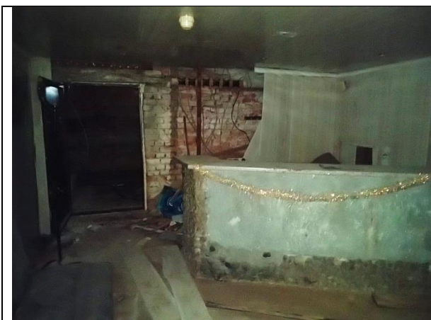
Фото 19. Внутреннее состояние Объекта оценки
