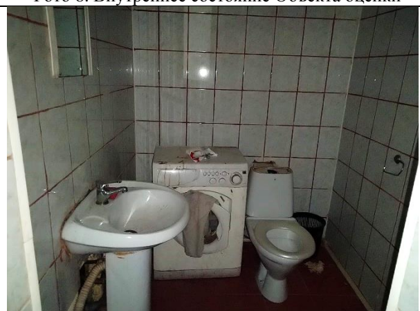
Фото 10. Внутреннее состояние Объекта оценки
