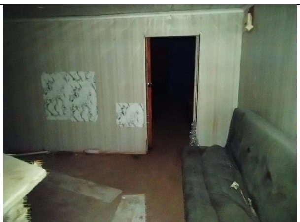
Фото 20. Внутреннее состояние Объекта оценки
