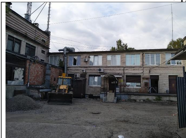
Фото 1. Вид здания, в котором расположен Объект оценки
