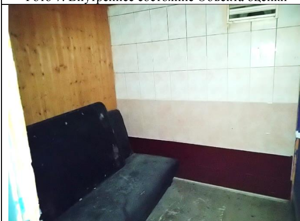
Фото 9. Внутреннее состояние Объекта оценки
