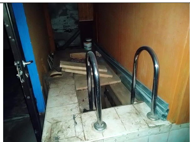
Фото 12. Внутреннее состояние Объекта оценки
