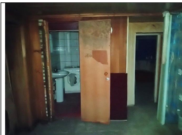
Фото 11. Внутреннее состояние Объекта оценки
