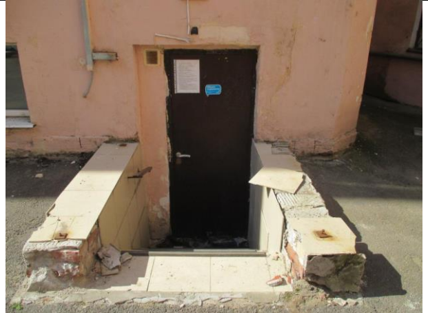
Фото № 8 – Вход в помещение со двора
