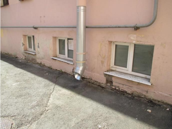
Фото № 7 – Расположение окон помещения
