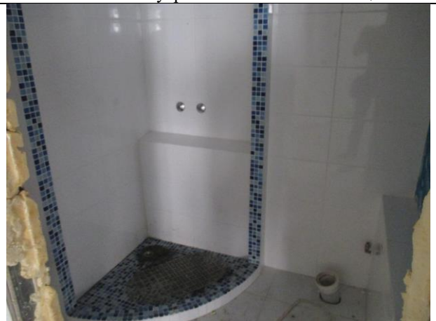
Фото № 18 – Внутреннее состояние помещения
