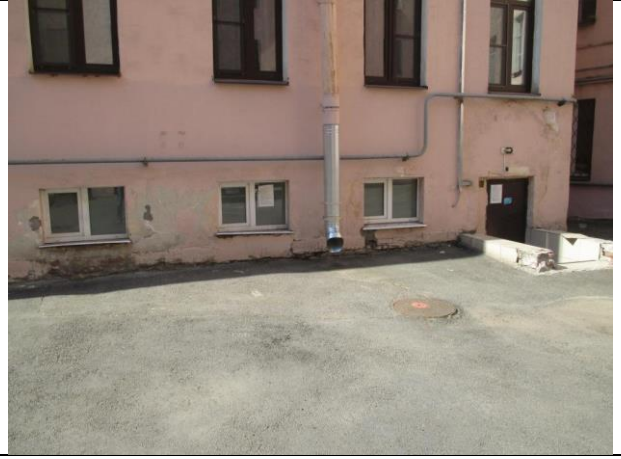
Фото № 6 – Расположение окон помещения
