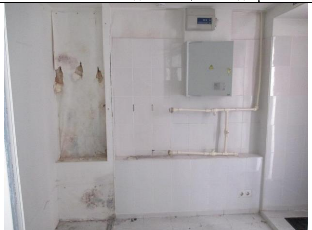
Фото № 10 – Внутреннее состояние помещения
