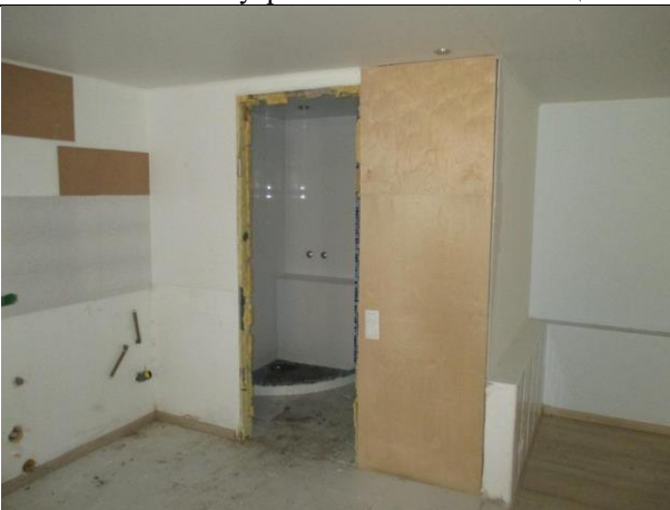
Фото № 17 – Внутреннее состояние помещения
