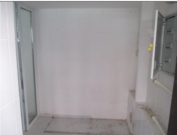
Фото № 9 – Внутреннее состояние помещения
