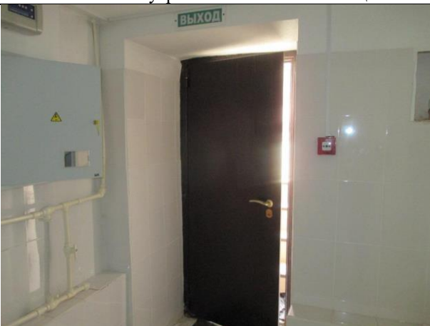
Фото № 11 – Внутреннее состояние помещения
