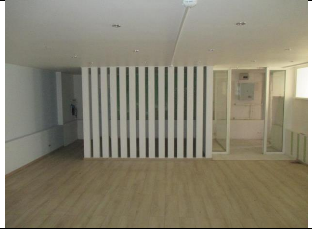
Фото № 14 – Внутреннее состояние помещения
