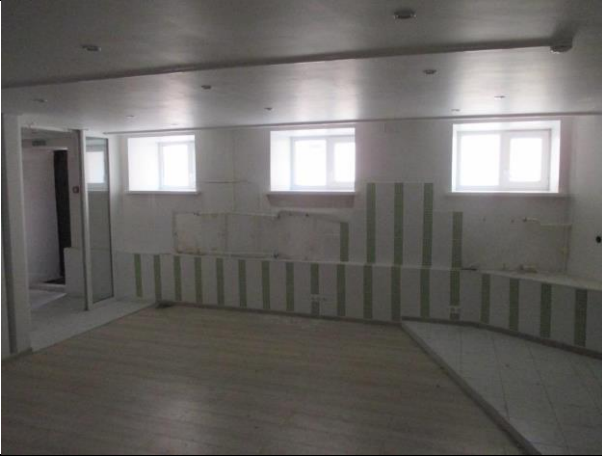
Фото № 13 – Внутреннее состояние помещения
