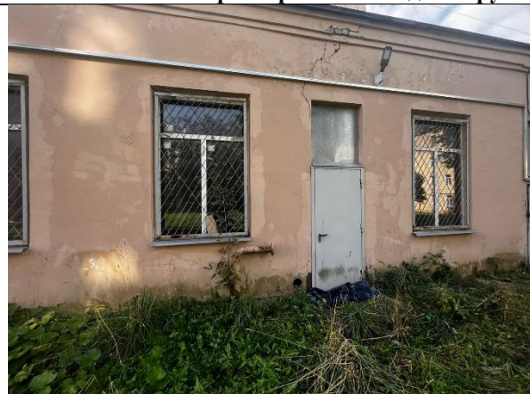
Фото 3. Отдельный вход со двора и окна Объекта оценки
