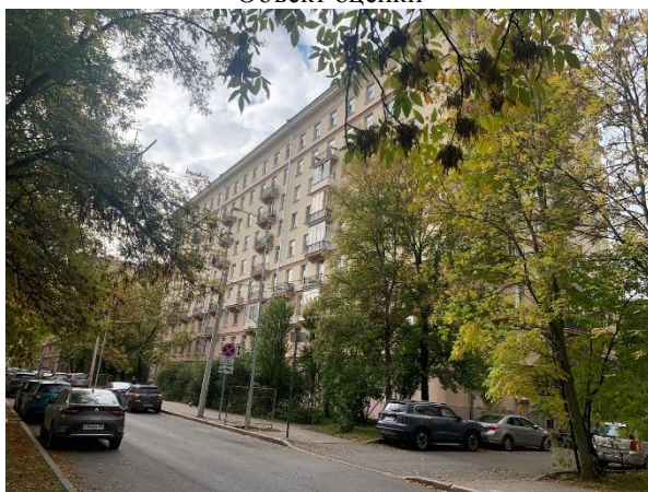
Фото 3. Вид здания, в котором расположен Объект оценки
