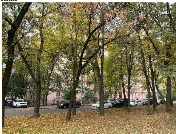
Фото 2. Вид здания, в котором расположен Объект оценки
