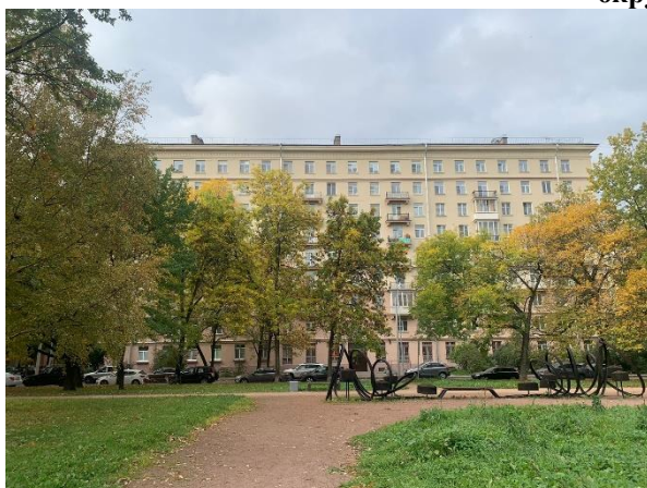
Фото 1. Вид здания, в котором расположен Объект оценки
