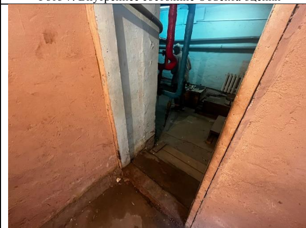
Фото 9. Внутреннее состояние Объекта оценки
