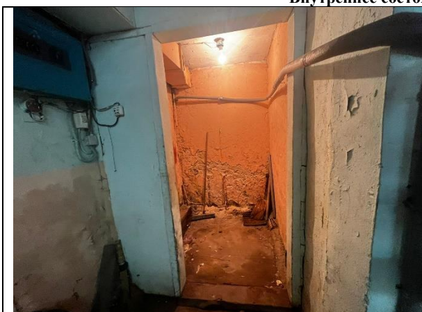
Фото 5. Внутреннее состояние Объекта оценки
