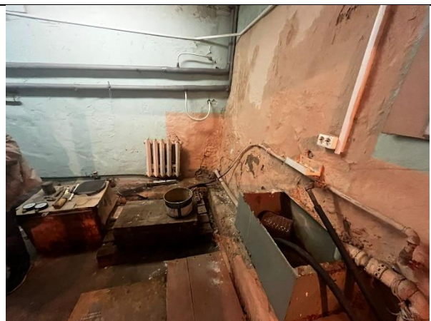
Фото 8. Внутреннее состояние Объекта оценки
