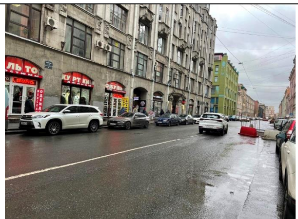
Фото 2. Ближайшее окружение Объекта оценки (Апраксин переулок)
