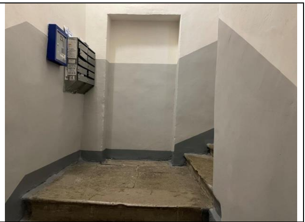
Фото 22. Лестничный проём Объекта оценки
