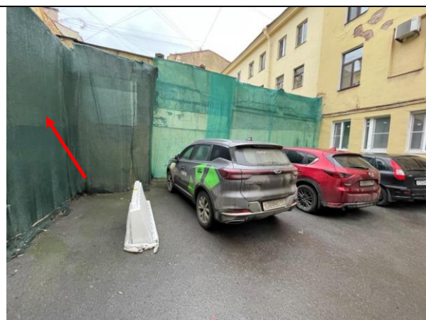
Фото 14. Вид здания расположения Объекта оценки
