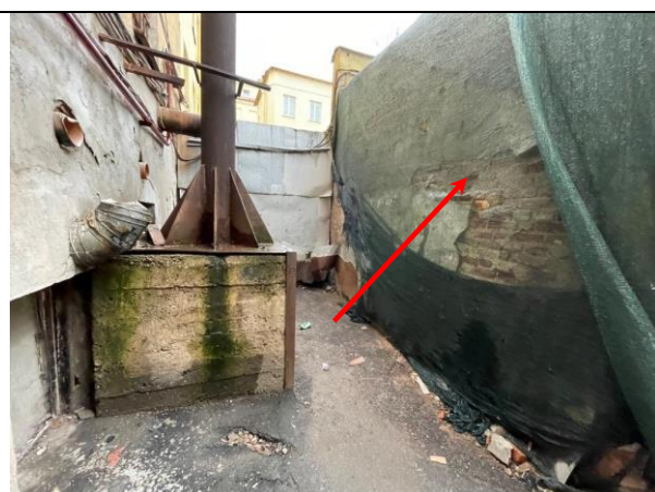
Фото 16. Вид здания расположения Объекта оценки
