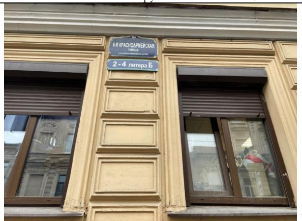
Фото 10. Ближайшее окружение Объекта оценки (Адрес Объекта оценки)
