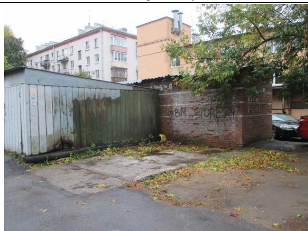
Фото № 5. Внешний вид здания
