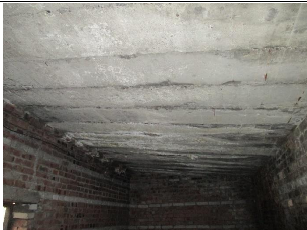
Фото № 13. Внутреннее состояние здания
