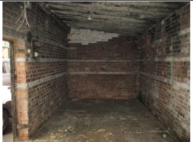
Фото № 16. Внутреннее состояние здания
