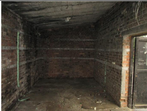
Фото № 15. Внутреннее состояние здания
