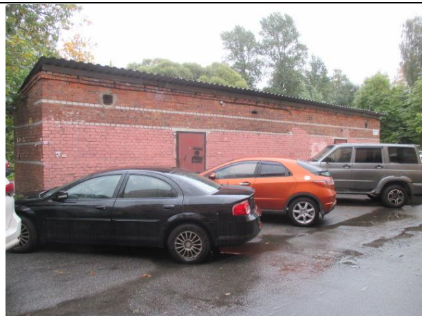
Фото № 4. Внешний вид здания
