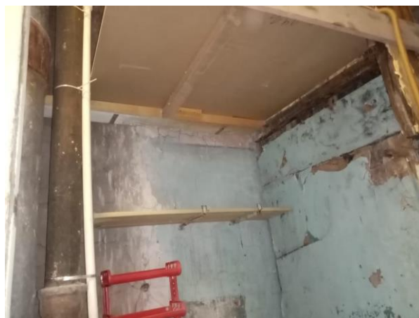
Фото 11. Внутреннее состояние Объекта оценки
