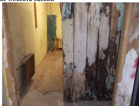
Фото 7. Внутреннее состояние Объекта оценки
