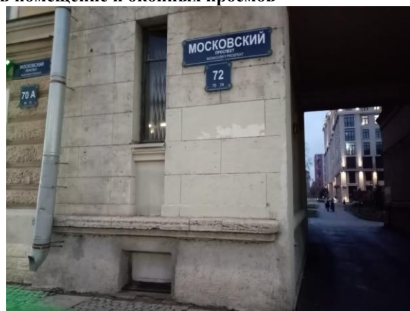
Фото 5. Вид окна Объекта оценки
