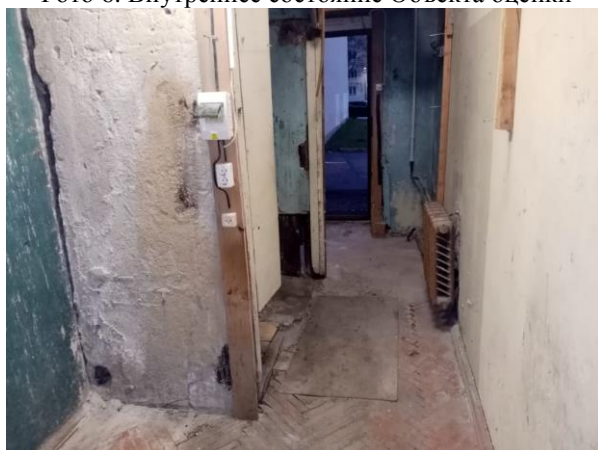
Фото 8. Внутреннее состояние Объекта оценки
