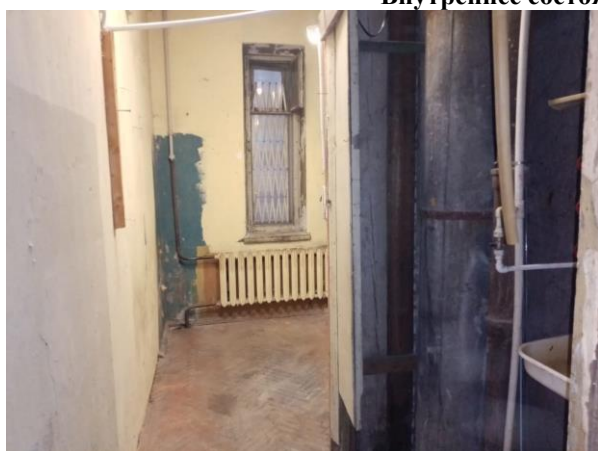
Фото 6. Внутреннее состояние Объекта оценки
