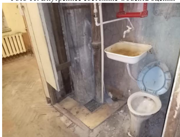
Фото 13. Внутреннее состояние Объекта оценки
