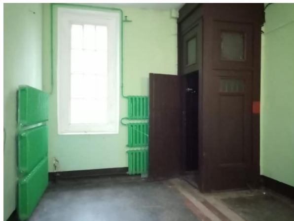
Фото 12. Вид ЛК 1 этажа
