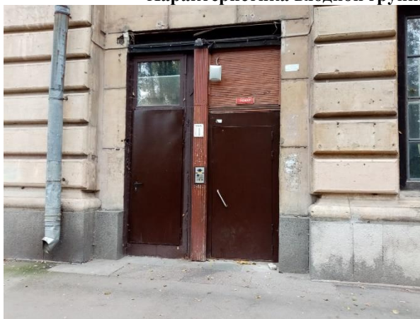
Фото 7. Общий вход с улицы
