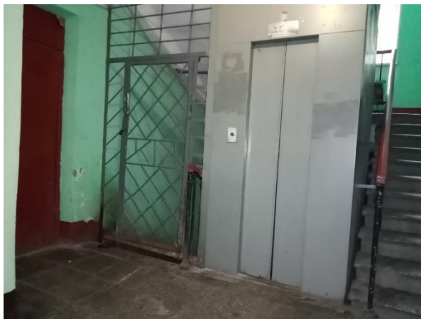
Фото 11. Вид ЛК 1 этажа
