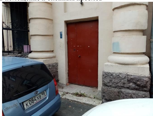
Фото 8. Общий вход со двора
