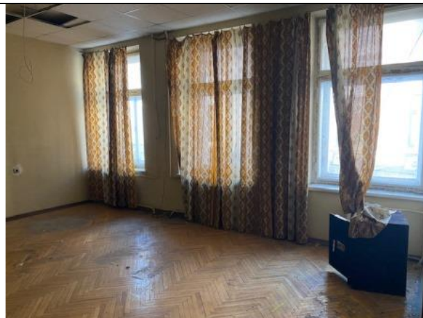
Фото № 16 – Внутреннее состояние помещения
