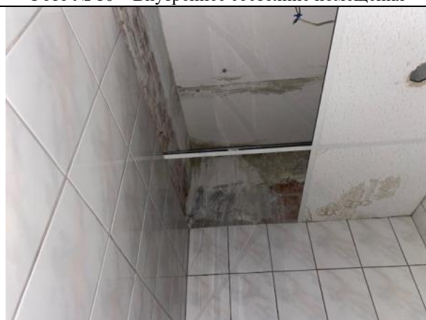
Фото № 12 – Внутреннее состояние помещения
