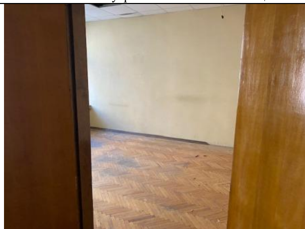
Фото № 20 – Внутреннее состояние помещения
