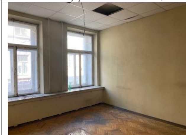
Фото № 19 – Внутреннее состояние помещения
