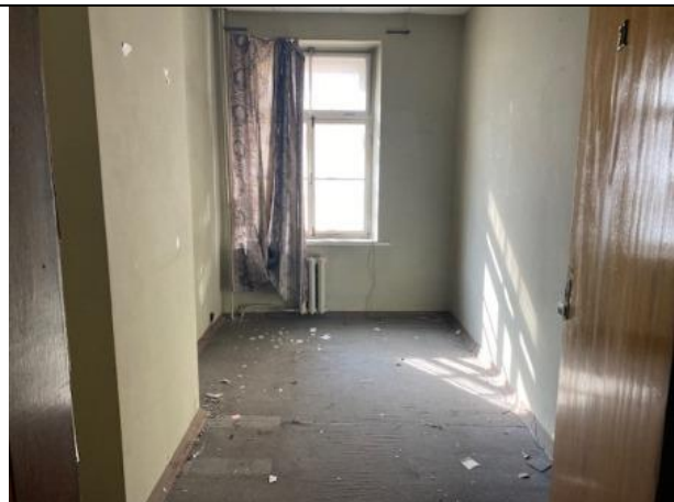
Фото № 8 – Внутреннее состояние помещения
