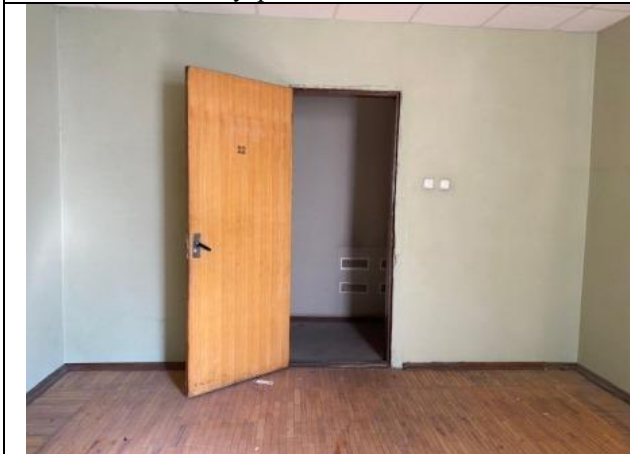
Фото № 9 – Внутреннее состояние помещения
