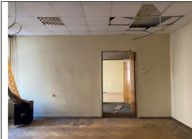
Фото № 15 – Внутреннее состояние помещения
