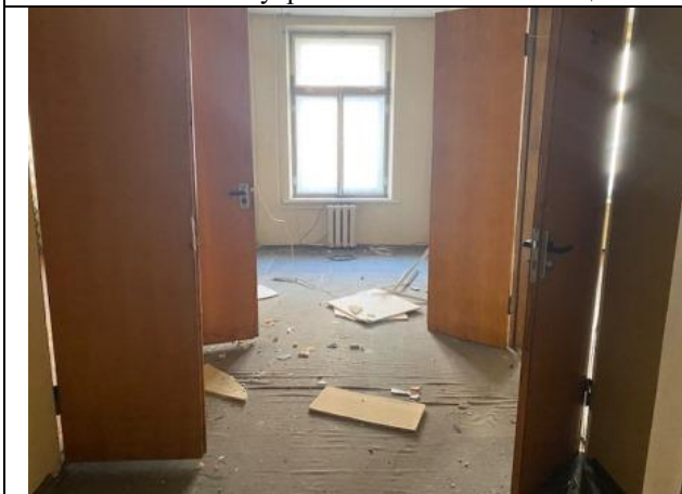
Фото № 21 – Внутреннее состояние помещения
