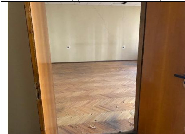
Фото № 17 – Внутреннее состояние помещения
