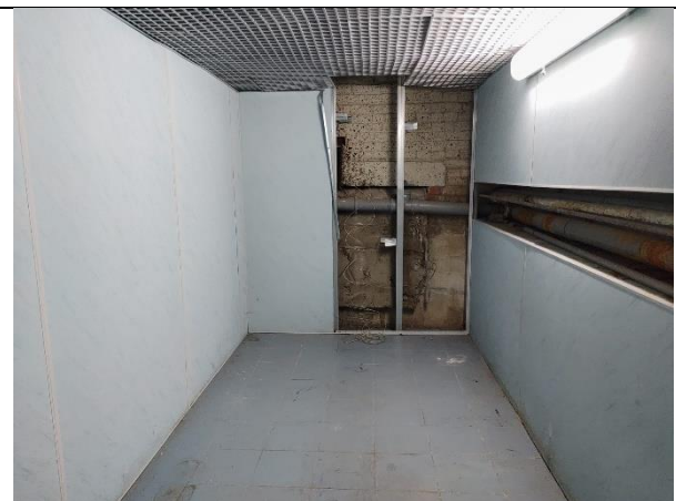
Фото 14. Внутреннее состояние Объекта оценки
