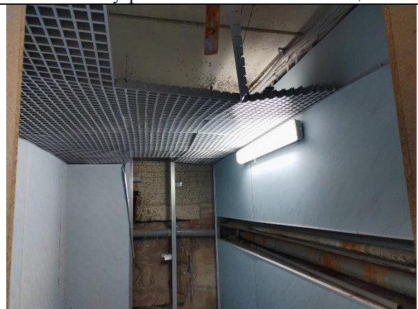
Фото 10. Внутреннее состояние Объекта оценки
