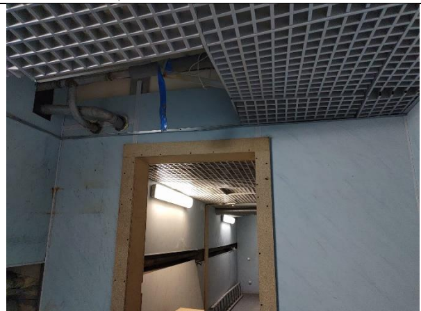
Фото 8. Внутреннее состояние Объекта оценки
