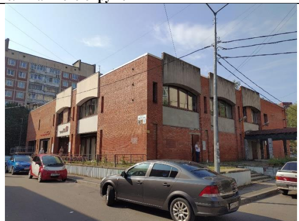
Фото 2. Вид здания, в котором расположен Объект оценки
