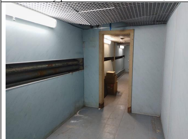
Фото 9. Внутреннее состояние Объекта оценки
