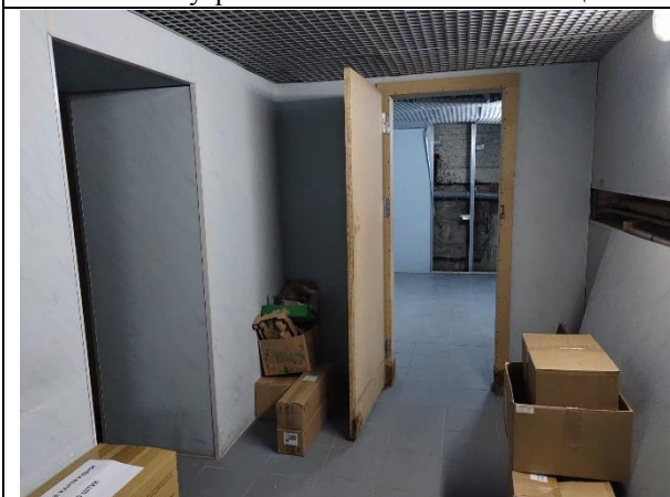
Фото 11. Внутреннее состояние Объекта оценки
