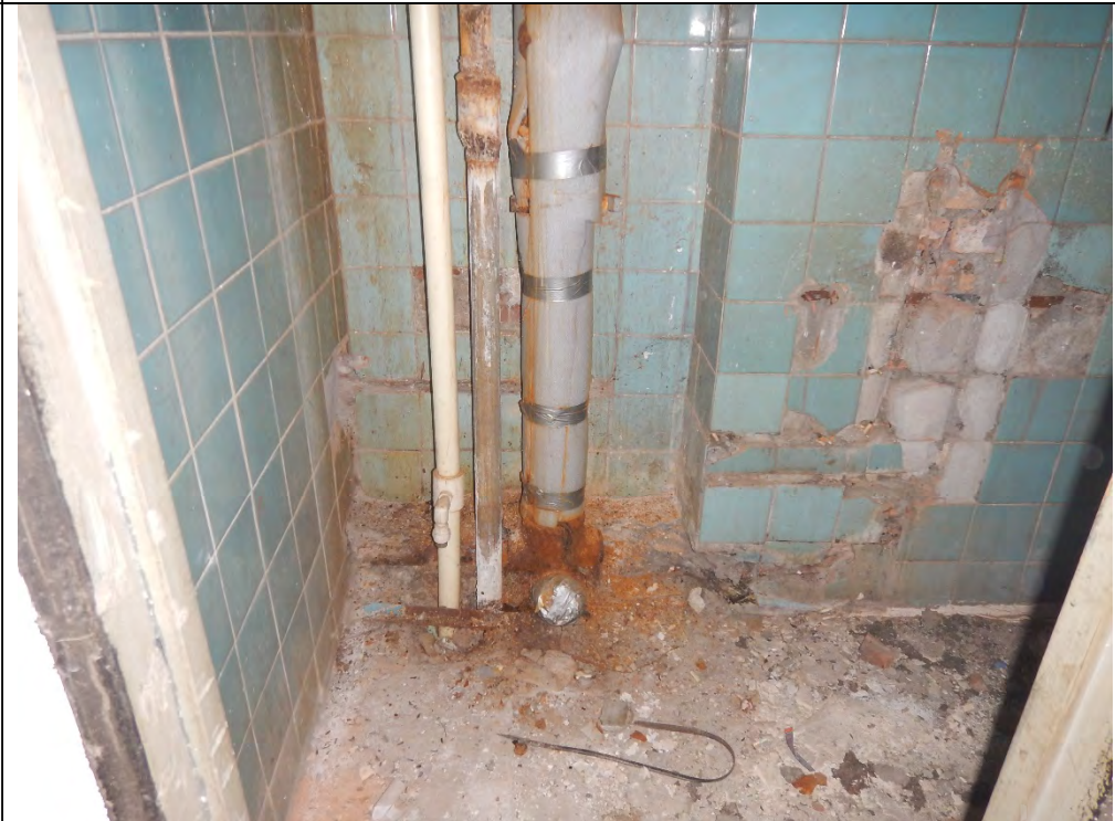
В ч.п. 7 Объекта демонтировано сантехническое оборудование (раковина и унитаз)
