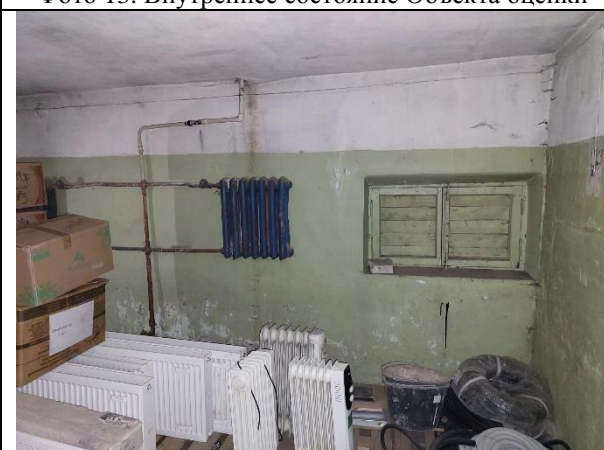
Фото 15. Внутреннее состояние Объекта оценки
