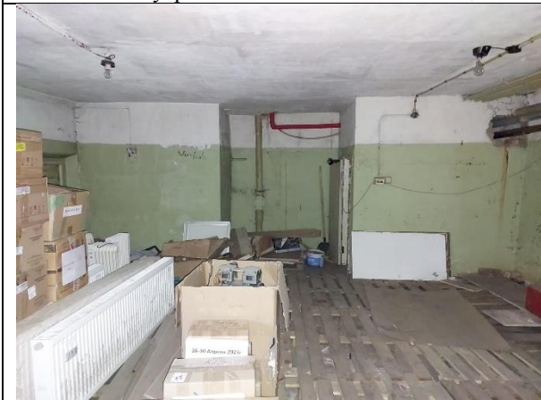
Фото 11. Внутреннее состояние Объекта оценки
