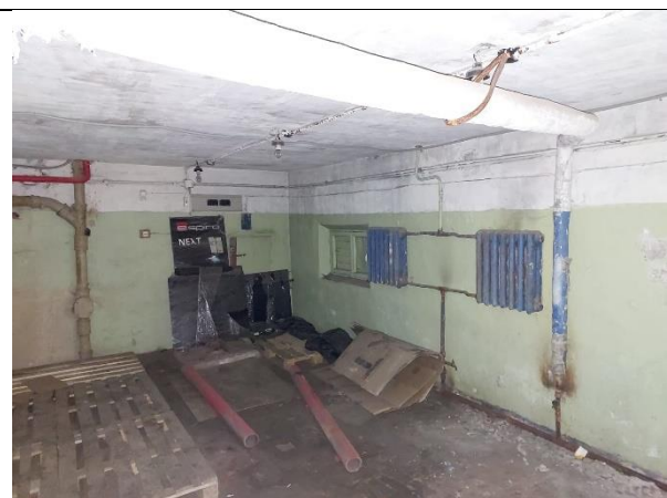
Фото 14. Внутреннее состояние Объекта оценки
