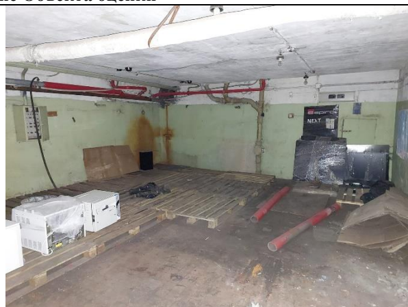
Фото 10. Внутреннее состояние Объекта оценки
