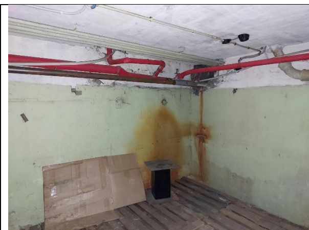
Фото 13. Внутреннее состояние Объекта оценки
