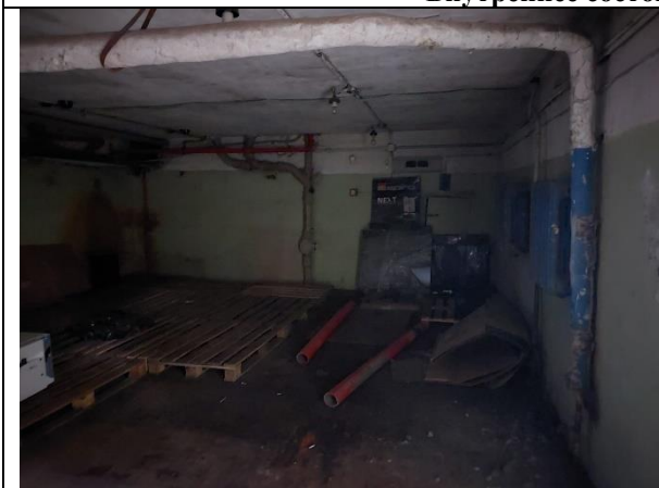
Фото 9. Внутреннее состояние Объекта оценки
