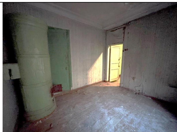
Фото 22. Типичное состояние Объекта оценки
