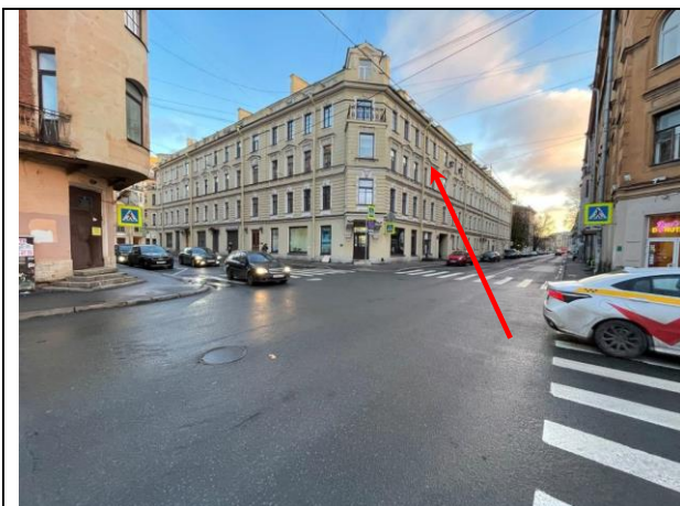
Фото 13. Вид здания расположения Объекта оценки
